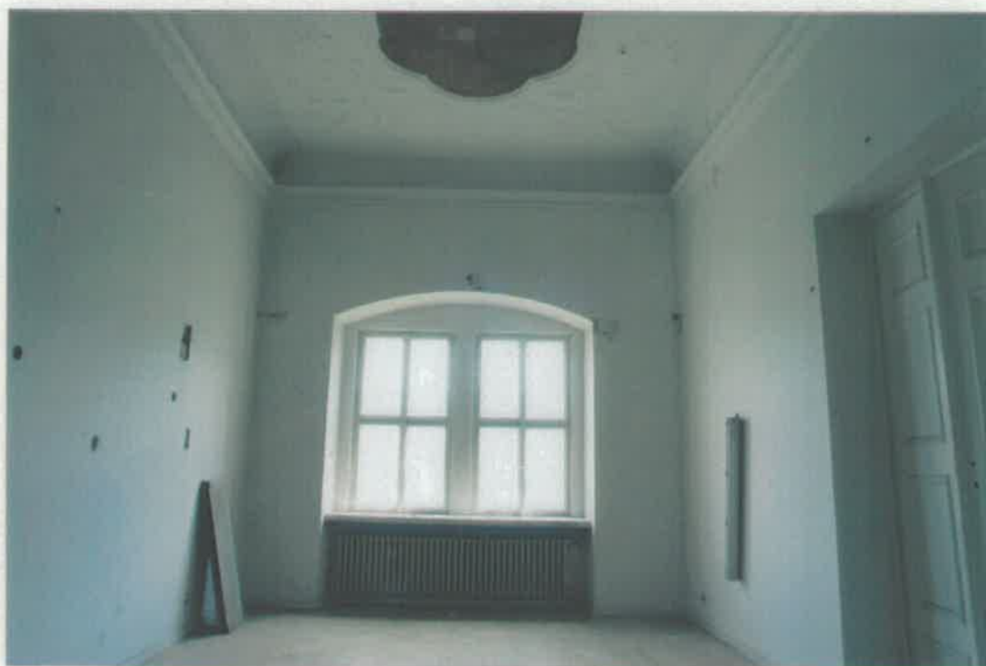
Místnost č. 2.33 – pohled jižním směrem.
