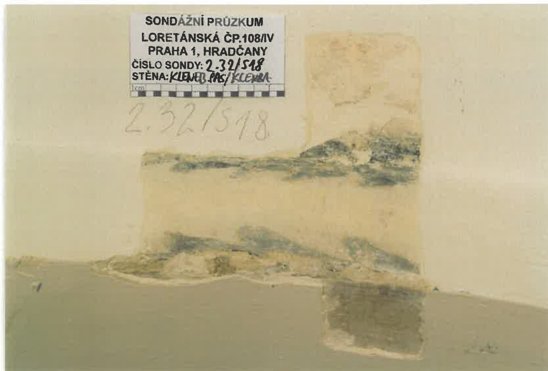
Prostor č. 2.32 - Sonda č. 18 dokládá dekorativní malované lemování na hraně zaklenutí schodiště a klenebního pasu.
