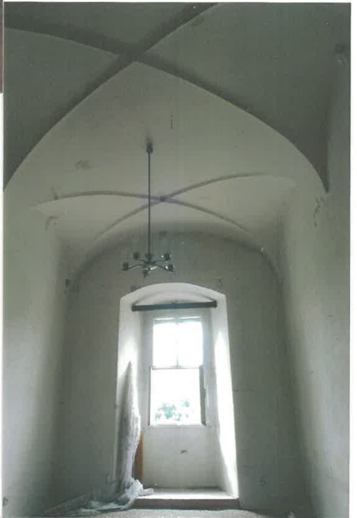
Místnost č. 1.36 - Pohled na jižní stěnu, okenní otvor a klenbu místnosti.
