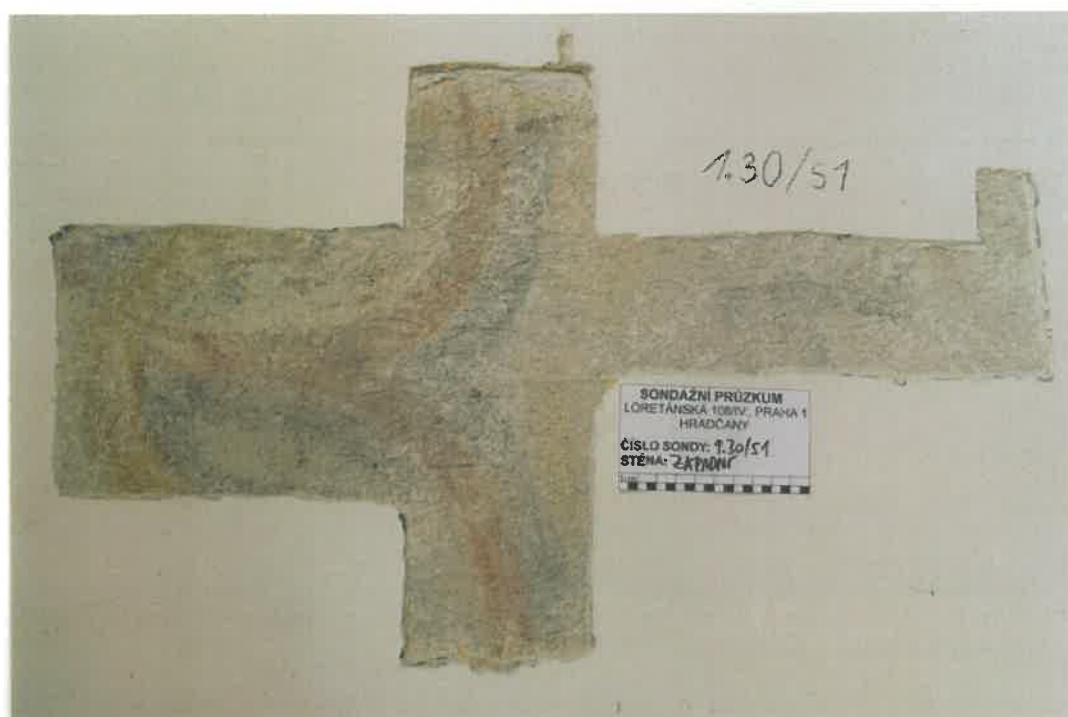
Místnost 1.30 - V soklové partii západní stěny (sonda č. 1) byla na omítce hrubého povrchu nalezena dekorativní malba.
