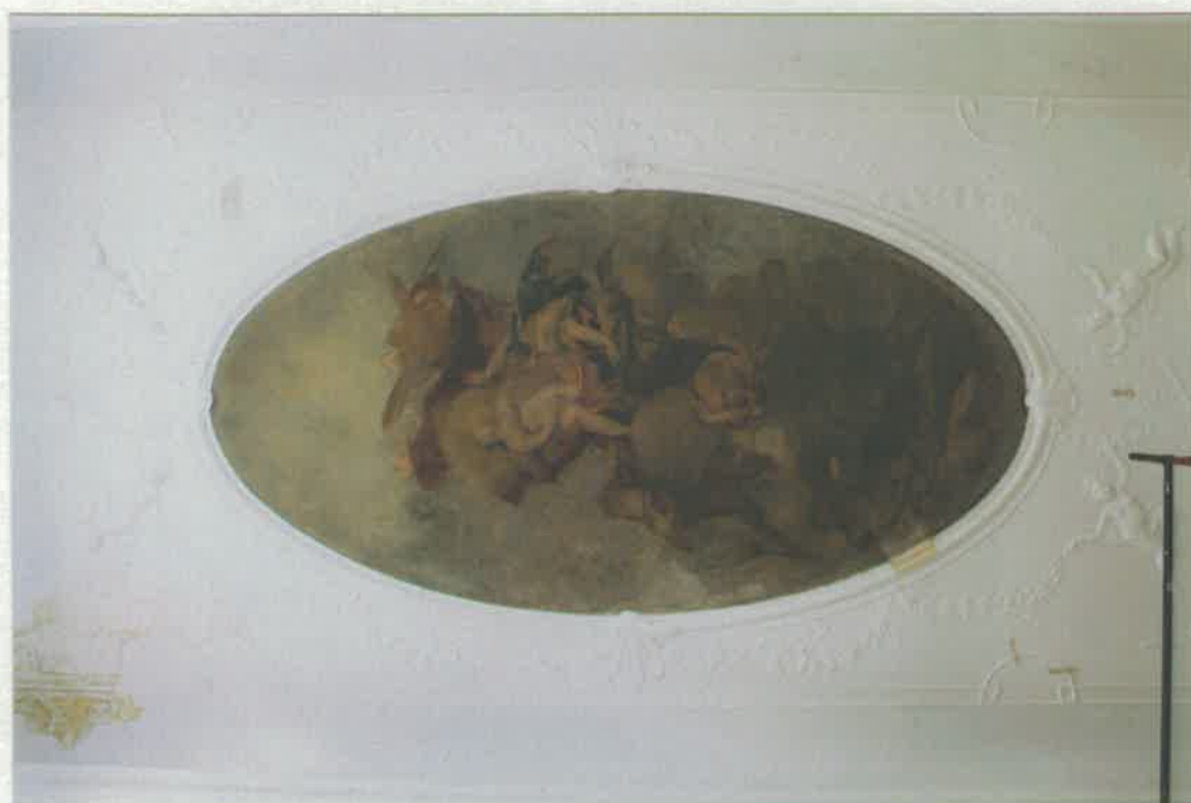
Místnost č. 2.36 – stav po provedení části sondážního průzkumu na nástropní malbě a štukaturách.
