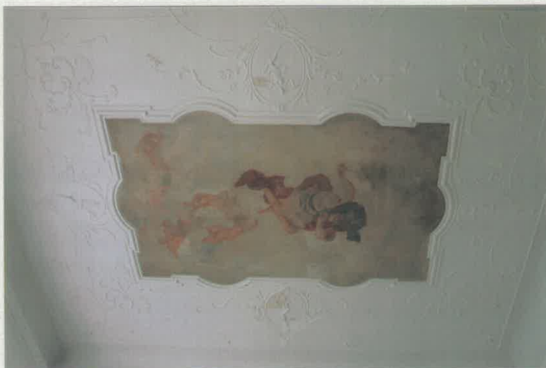
Místnost č. 2.35 – stav po provedení sondážního průzkumu na nástropní malbě a štukaturách.
