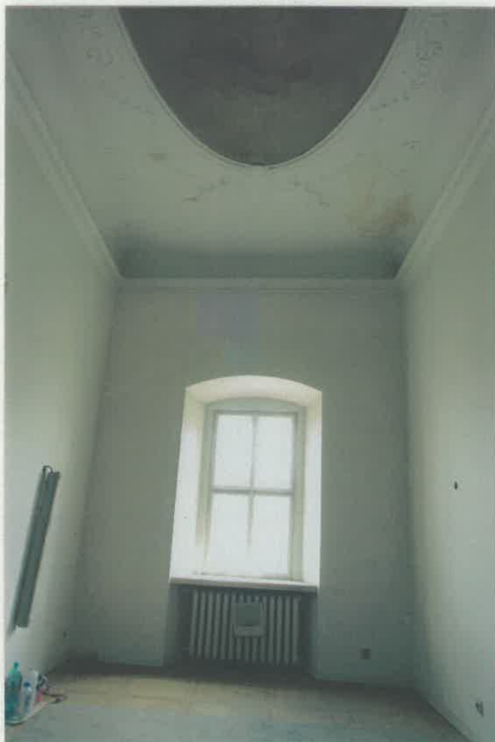
Místnost č. 2.36 – pohled jižním směrem.
