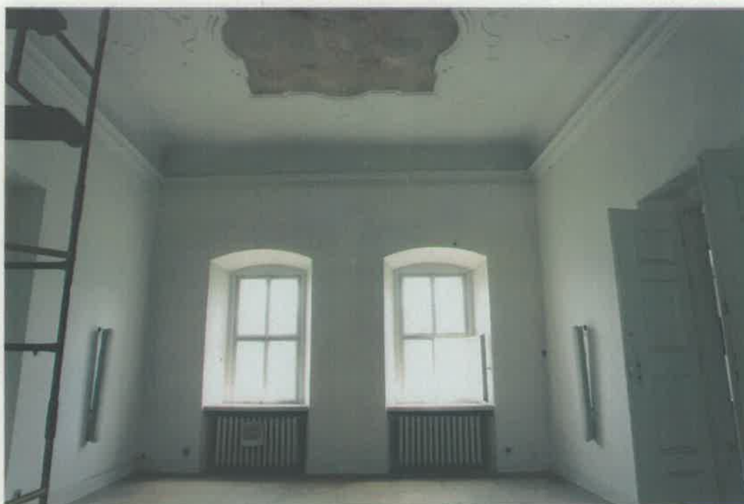
Místnost č. 2.35 – pohled jižním směrem.
