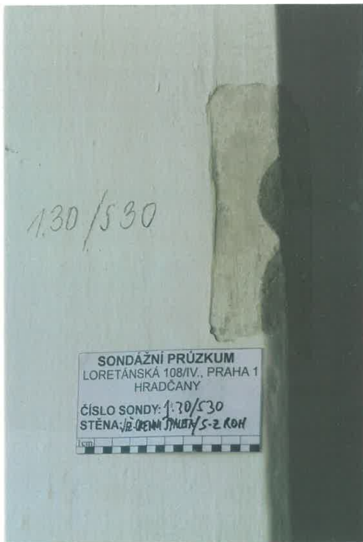
Místnost 1.30 - Sonda č. 30 na jihozápadním nároží okenní špalety s charakteristickým vytvarováním hrany a jejím probráním v horní části.
