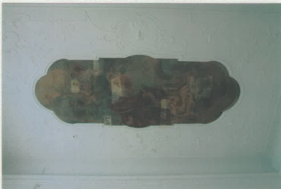
Místnost č. 2.33 – stav po provedení sondážního průzkumu na nástropní malbě.
