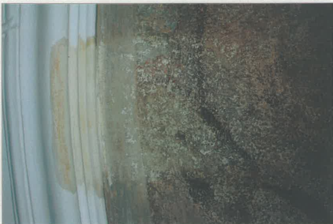
Místnost č. 2.36 – sondážní průzkum ve vrstvách povrchových nečistot, ztmavlých fixází a přemaleb, detaily.
