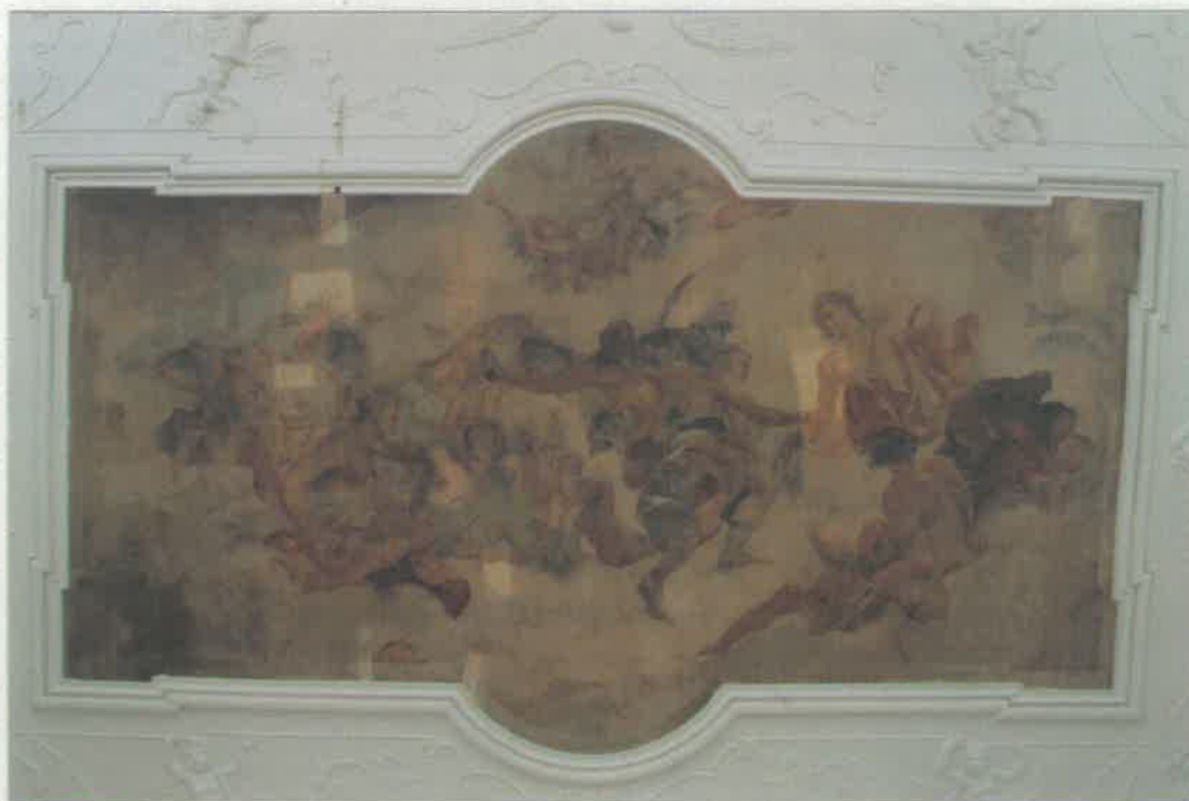
Místnost č. 2.34 – celkový pohled na nástropní malbu po provedení sondážního průzkumu.
