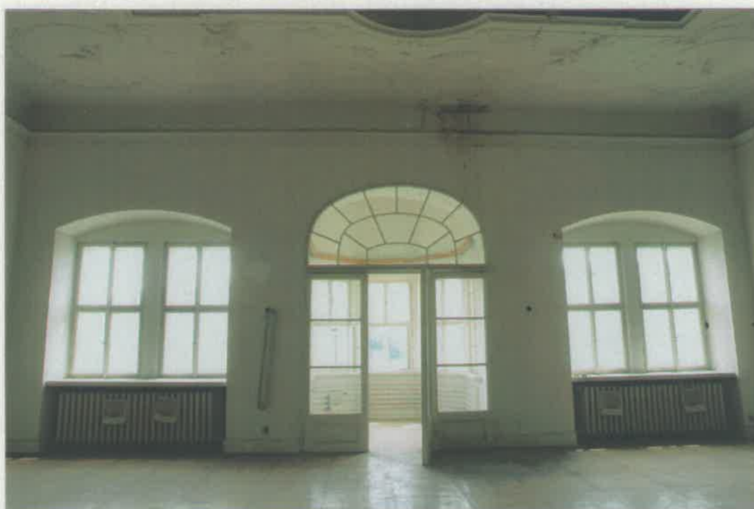
Místnost č. 2.34 – pohled jižním směrem.
