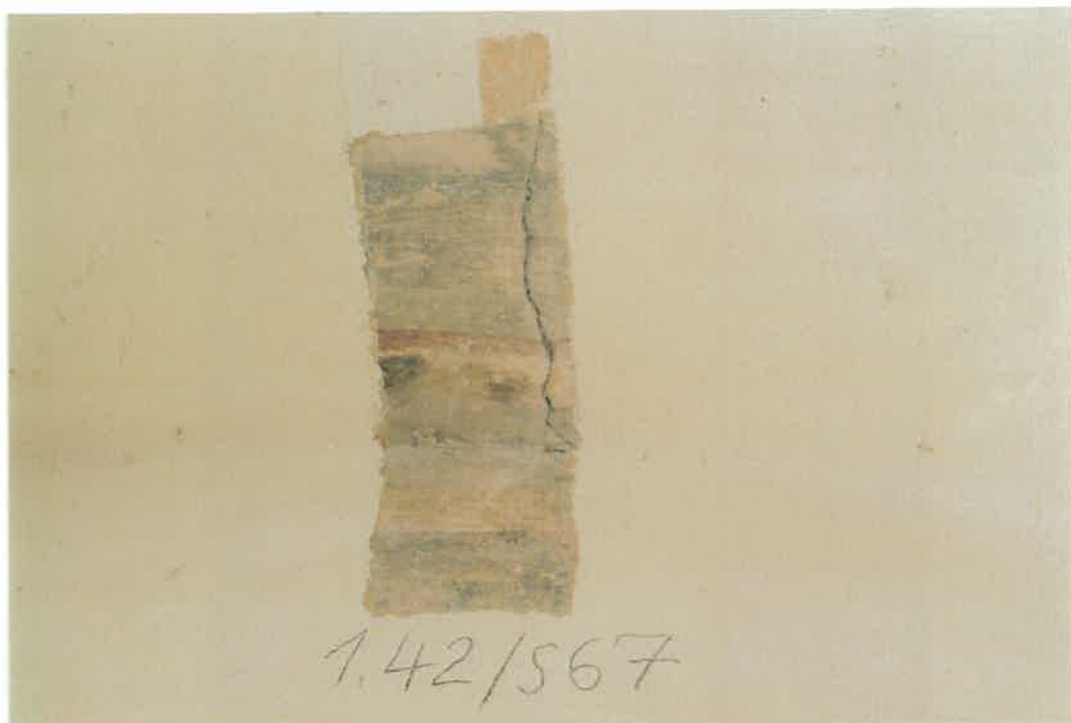
Prostor č. 1.42 - Sonda č. 67 na rozhraní stěny a klenby v západní části chodby. Dokládá též malířskou dekorativní výzdobu, která je však poněkud jiná než malba nalezená ve východní části chodby.
