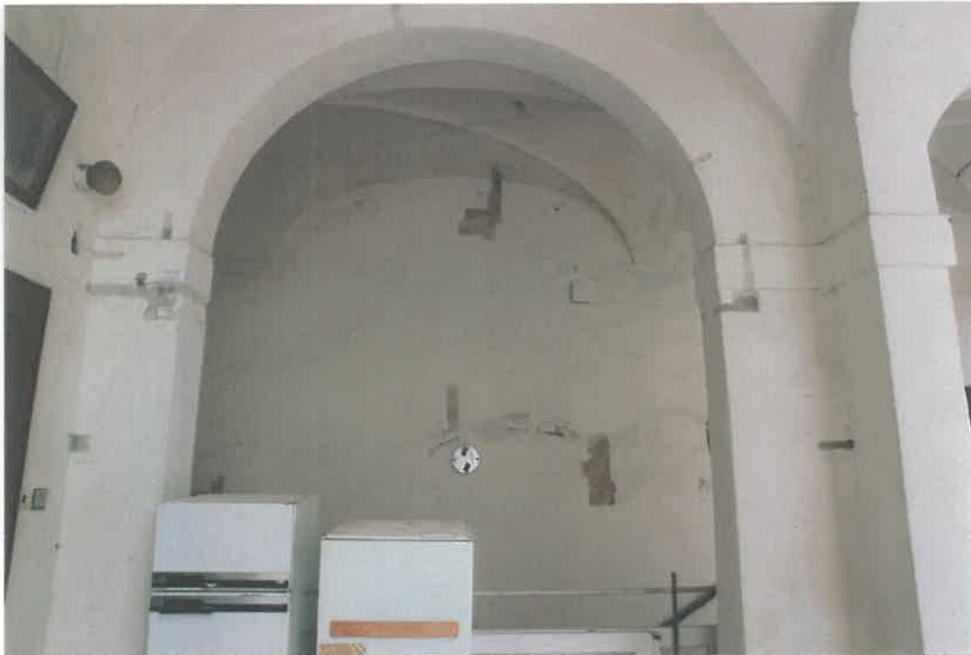
Prostor č. 1.41 a 1.42 - Pohled na část jižní stěny a situaci kolem východní části arkády. Chodba je do prostoru dvora otevřena arkádou se třemi oblouky.
