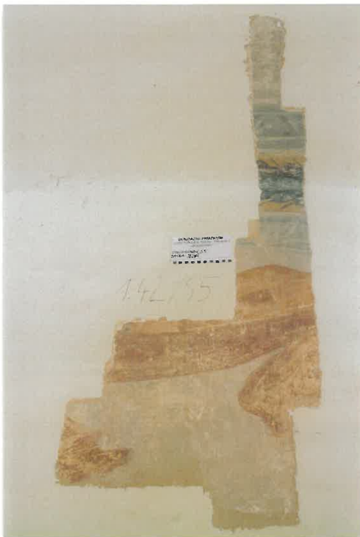
Prostor č. 1.42 - Sonda č. 5 provedená na přechodu jižní stěny a klenby. V tomto místě je manýristická dekorativní malba na kletovaných omítkách mimořádně dobře dochovaná (viz popis v textu dokumentace).
