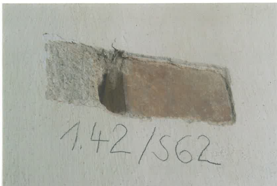
Prostor č. 1.42 - Sonda č. 62. Dokládá zadržný průstup v severní stěně (mezi chodbou 1.42 a současným vstupem do residence). Je zde zachycena kletovaná omítka okrové barevnosti s charakteristicky vytvarovanou nárožní hranou.
