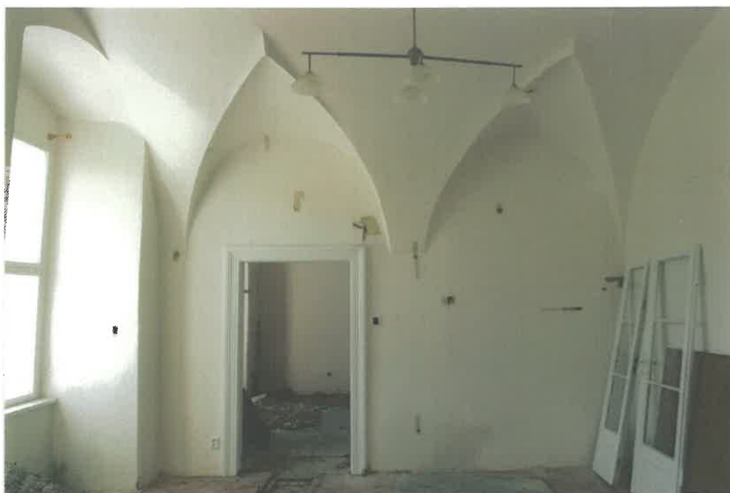
Místnost č. 15 - pohled na západní stěnu.
