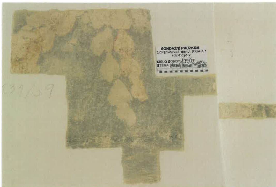
Místnost č. 1.31 - Sonda č. 9, provedená na podhledu klenebního pasu mezi arkýřem a prostorem místnosti, doložila přítomnost mladšího snad barokního (?) malovaného rostlinného dekoru.
