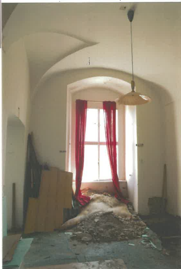
Místnost č. 14 - pohled do místnosti jižním směrem. V jihozápadním rohu místnosti (na fotografii vpravo dole) byla během SHP lokalizována studna.
