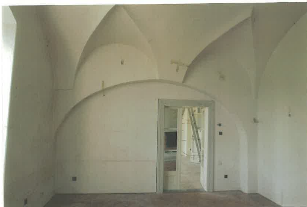
Místnost č. 19 - pohled na západní stěnu.
