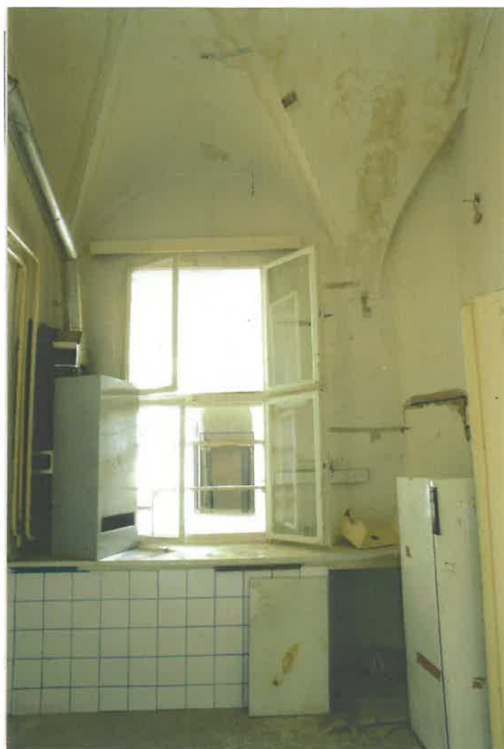
Místnost č. 1.28 - Pohled na západní stěnu místnosti s okenním otvorem vedoucím nad schodiště v prostoru 1.42.
