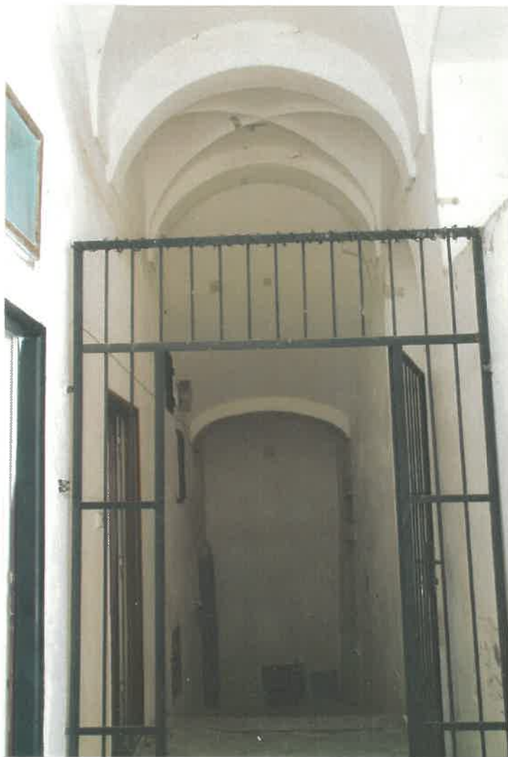
Prostor č. 1.42 - Pohled na západní část chodby.
