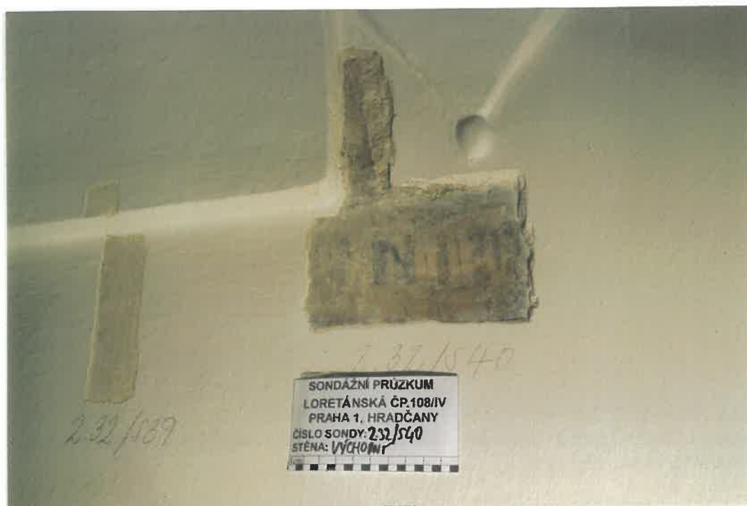
Prostor č. 2.32 - Sonda č. 40 na východní stěně v partii přechodu kolmé stěny a klenby. Dekorativní malba na kletované omítce podobně členěná jako na některých nalezených maľovaných trámech (např. v místnosti č. 2.22 či 2.18) a fragmentech vlysů mezi trámy.
