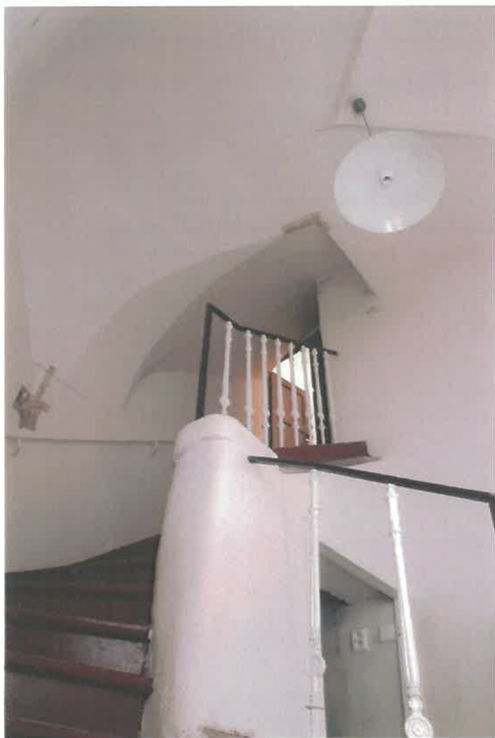
Místnost č. 13 - pohled do prostoru schodiště ke vstupu z chodby (1.42).
