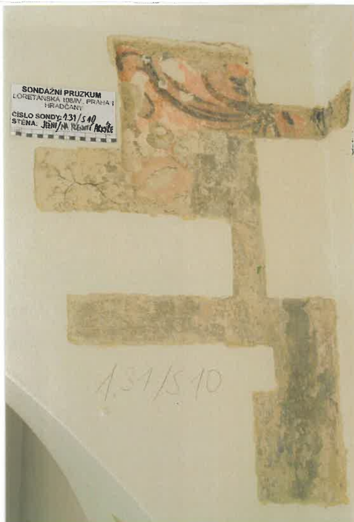
Místnost č. 1.31 - Sonda č. 10 ve cviklu klenutí vstupu do arkýře dokládá existenci několika fází malířské výzdoby. Ve starší z nich, která je osamoceným fragmentem, jde o dekorativní malbu na kletované nejstarší omítce, provedenou černou linkou na červeném podkladě, mladší šedá je vrstvou, která souvisí s nalezeným rostlinným dekorem v sondě č. 9.
