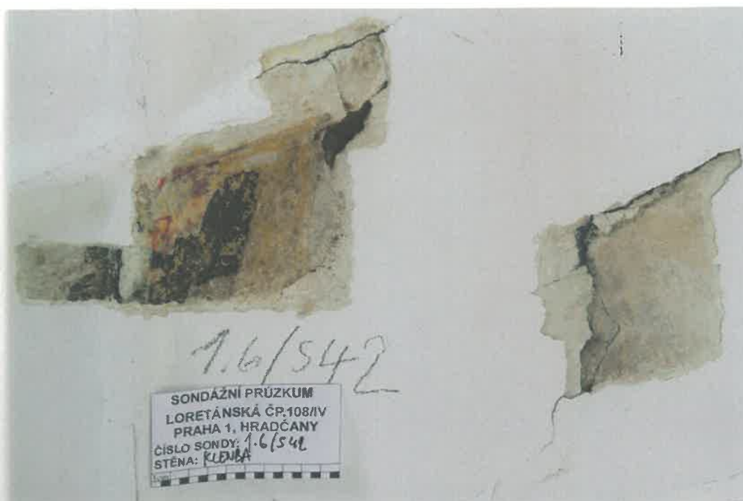
Prostor č. 1.6 (Průjezd) - Sonda č. 42. Místa jsou fragmenty původní dekorativní malby dochovány v překvapivě barevné intenzitě.
