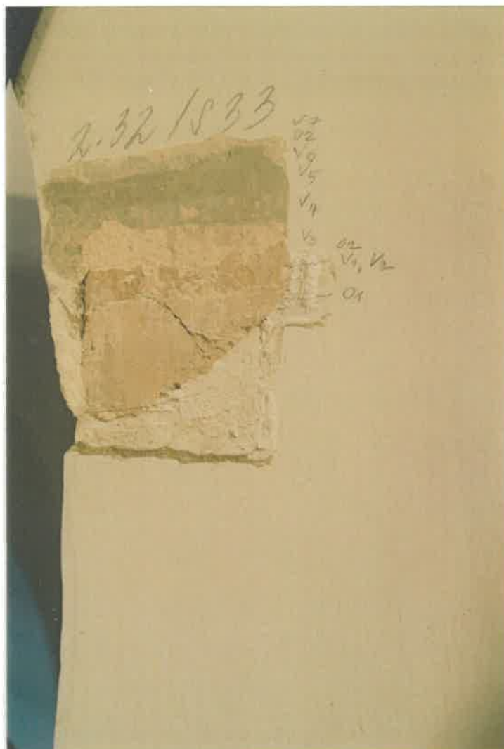
Prostor č. 2.32 - Sonda č. 33 dokládající stratigrafii nátěrů na kletované omítce.
