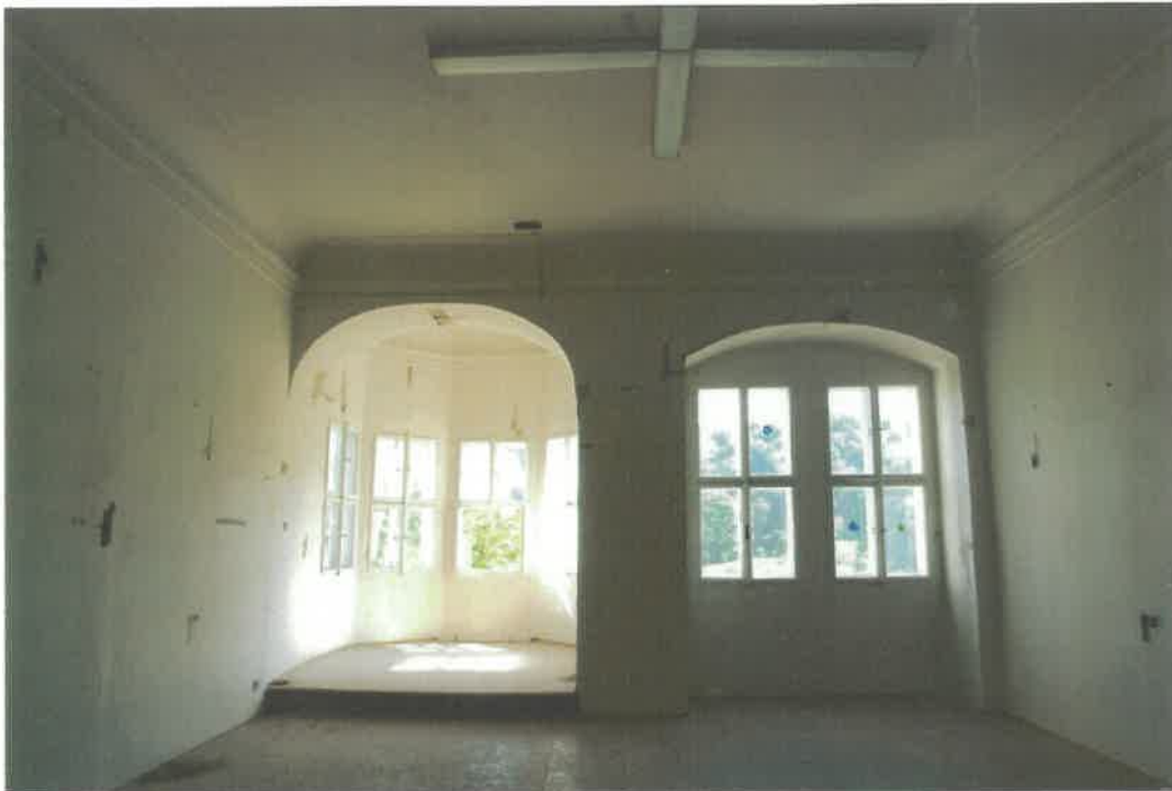
Místnost č. 1.31 - Pohled na jižní stěnu s prostorem arkýře.
