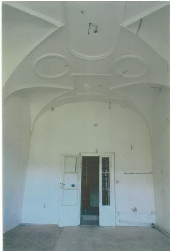
Místnost č. 1.29 - Pohled na severní stěnu a klenbu místnosti.
