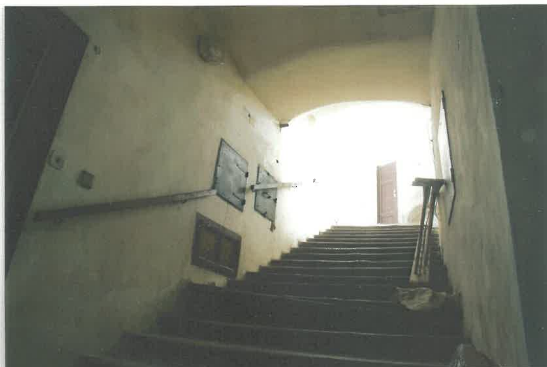
Prostor č. 1.42 - Pohled od paty schodiště západním směrem.
