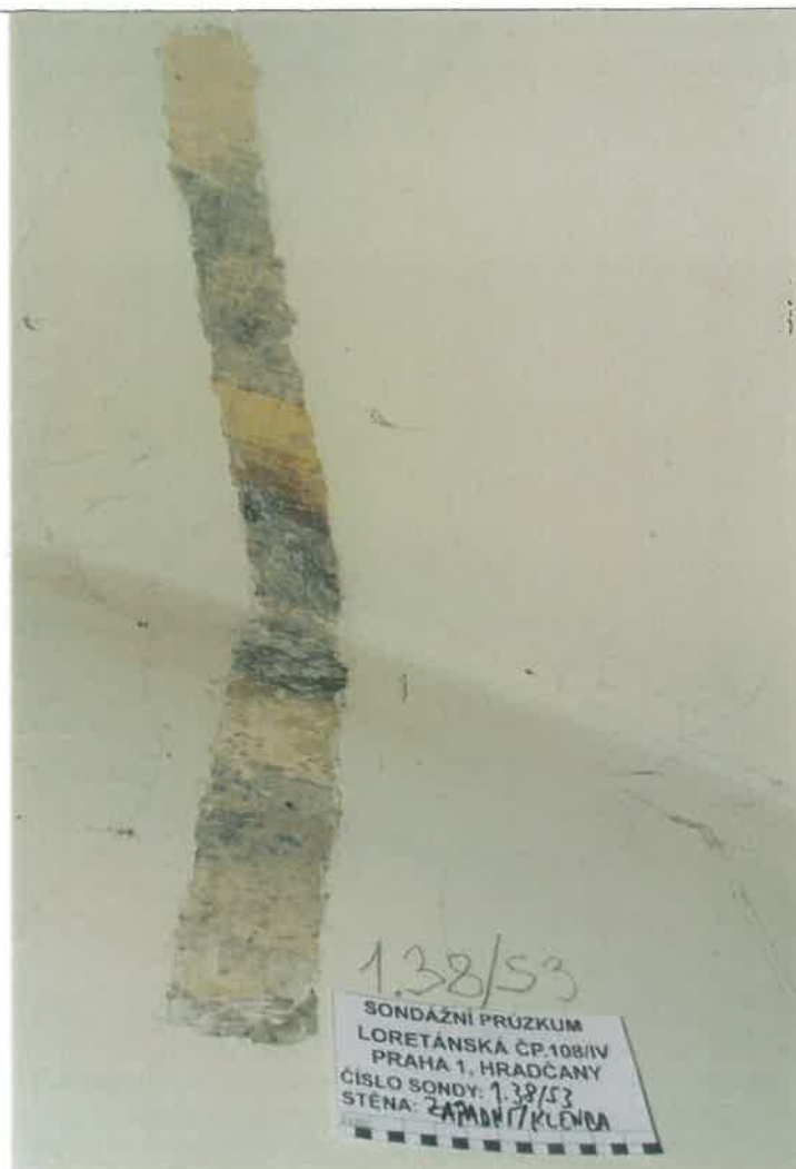
Prostora č. 1.38 - Sonda č. 3 na přechodu klenby a západní stěny dokládá malířskou výzdobu identickou s výzdobou v místnosti 1.36, se kterou tvořil tento prostor jeden celek. Zde je malba podstatně lépe dochovaná, než v sousední místnosti 1.36.
