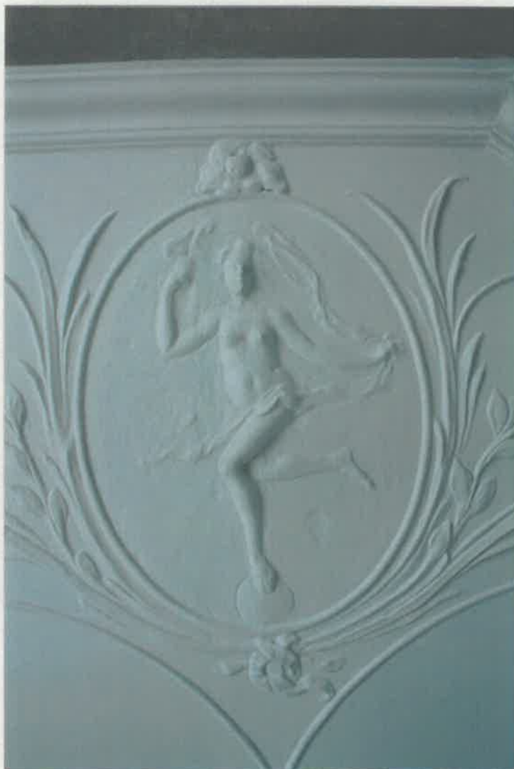
Místnost č. 2.35 – strop, západní část, detail štukové výzdoby před zahájením sondážního průzkumu.
