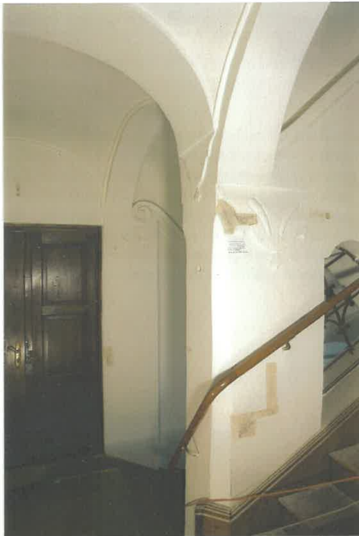
Prostor schodiště č. 2.32 - Pohled na centrální pilíř schodiště.
