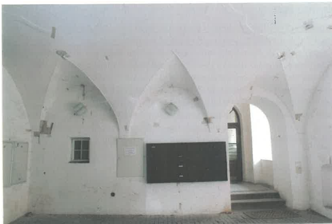
Prostor č. 1.6 (Průjezd) - Pohled na východní stěnu se vstupem do severního křídla objektu.
