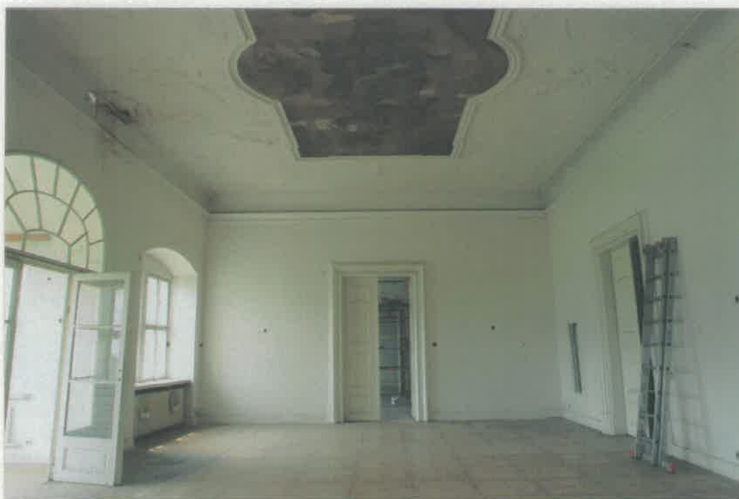
Místnost č. 2.34 – pohled západním směrem.
