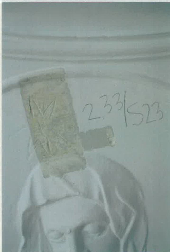
Místnost č. 2.33 – strop, sonda S23, postupné snímání nepůvodních monochromních nátěrů. Původní povrchová úprava - tenký v barvě slonové kosti.
