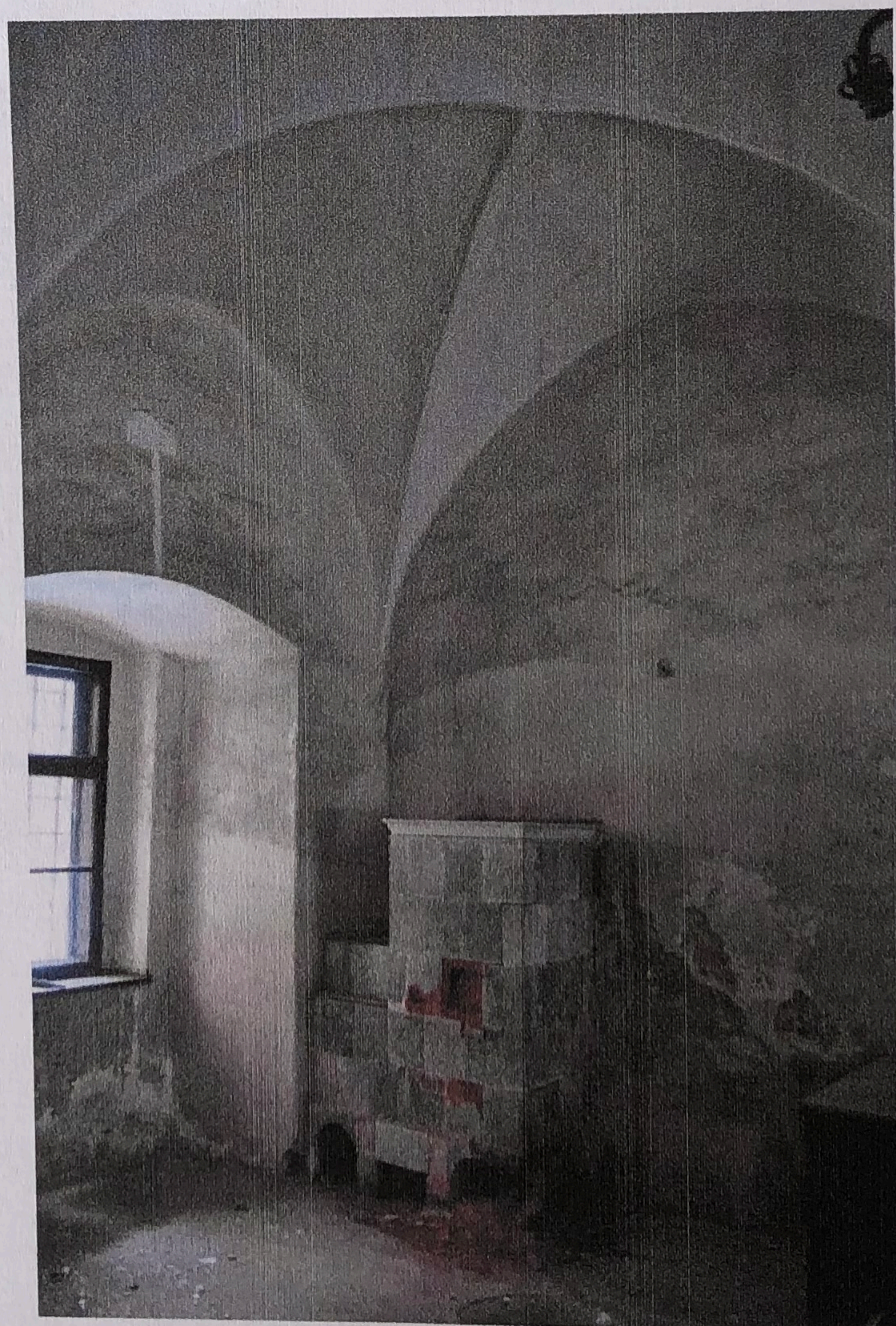
Obr.11,12: pohled do místnosti na západní část místnosti s vyznačením provedených sond. Druhý obrázek pohled na jihovýchodní část.
