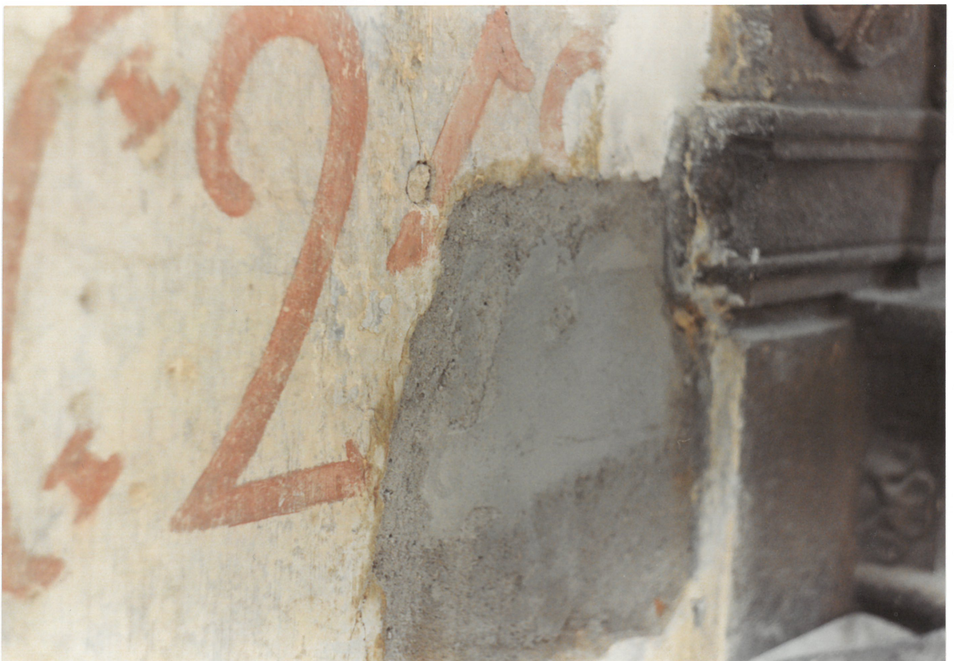
ČÁST ODKRYTÉ ČÍSLICE VEDLE VSTUPNÍHO PORTÁLU
