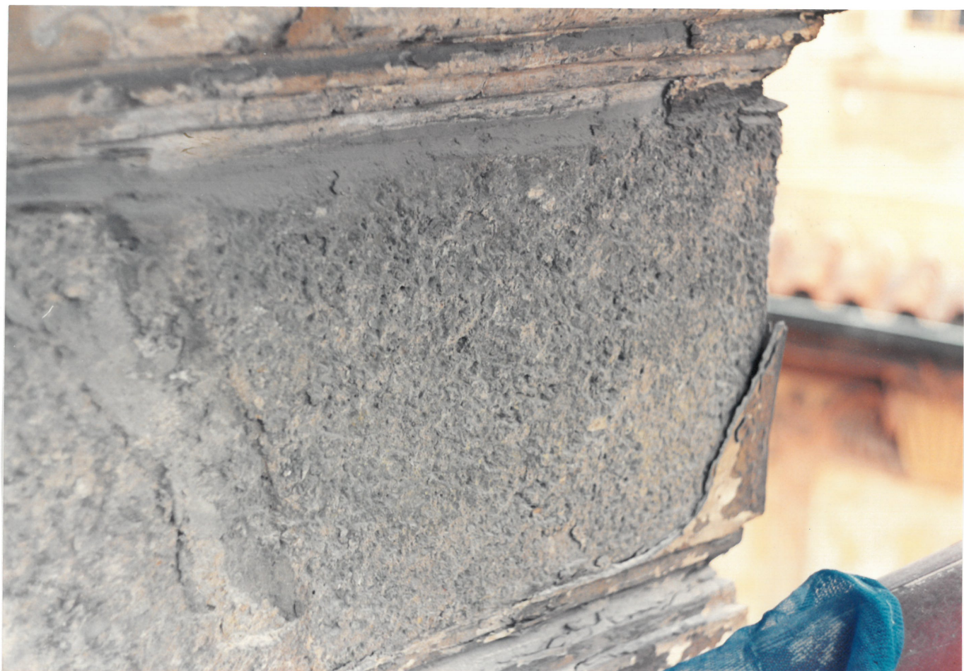
DETAIL PŮVODNÍHO ZOSOVÁNÍ ARMOVANÉHO NÁROŽÍ
