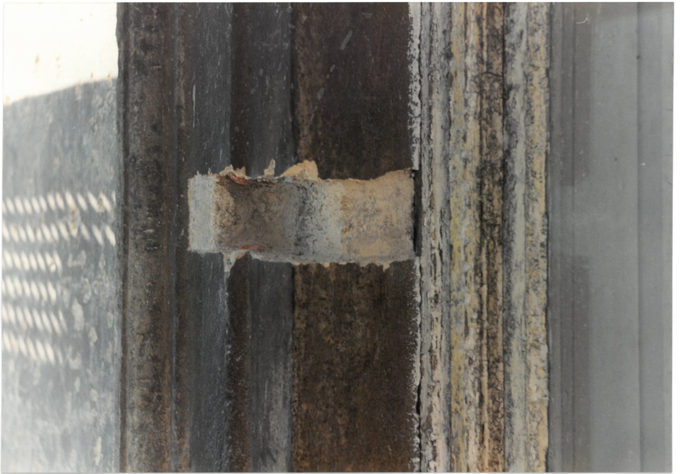
SONDA V OKEHNÍM OSTĚNÍ
