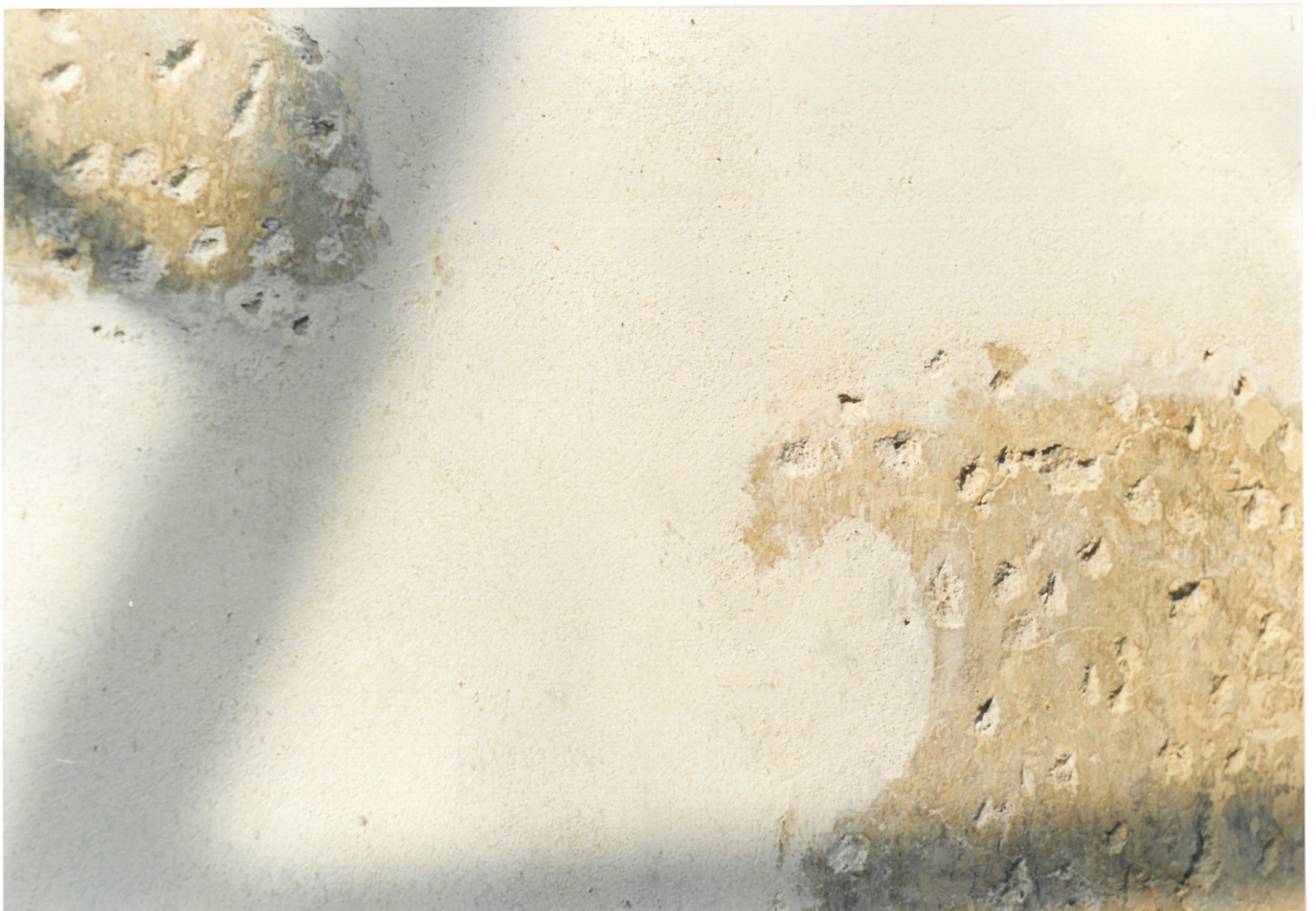
DETAIL PROVEDENÝCH OPRAV V PRŮB. REST. NA HLADKÝCH PLOCHÁCH S PEKOVÁNÍM NA PŮVODNÍ ŠTUKOVÉ VRSŤVĚ
