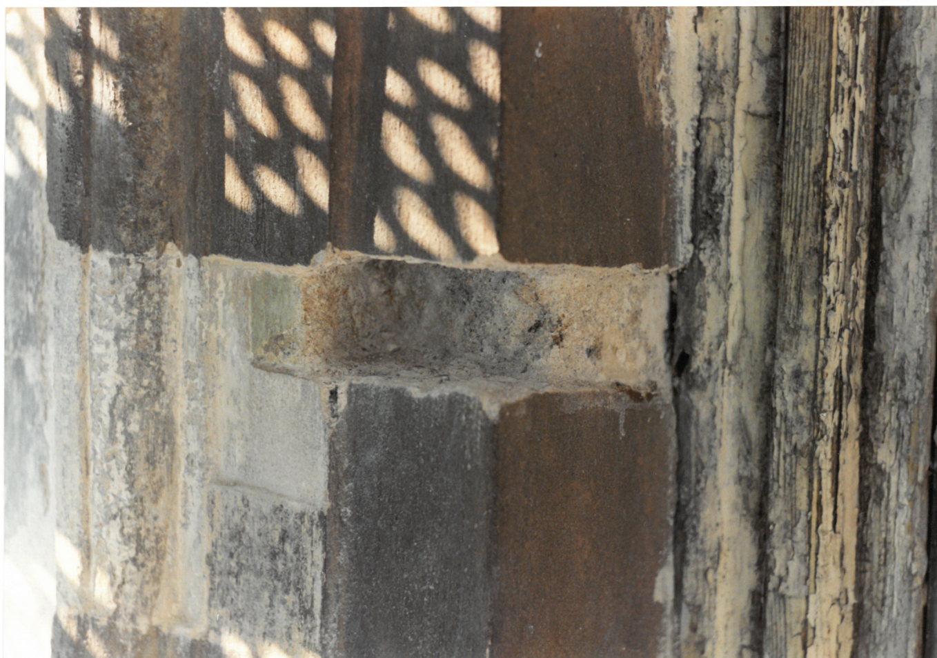
SONDA V DŘEVNÍM OSTEŇÍ
