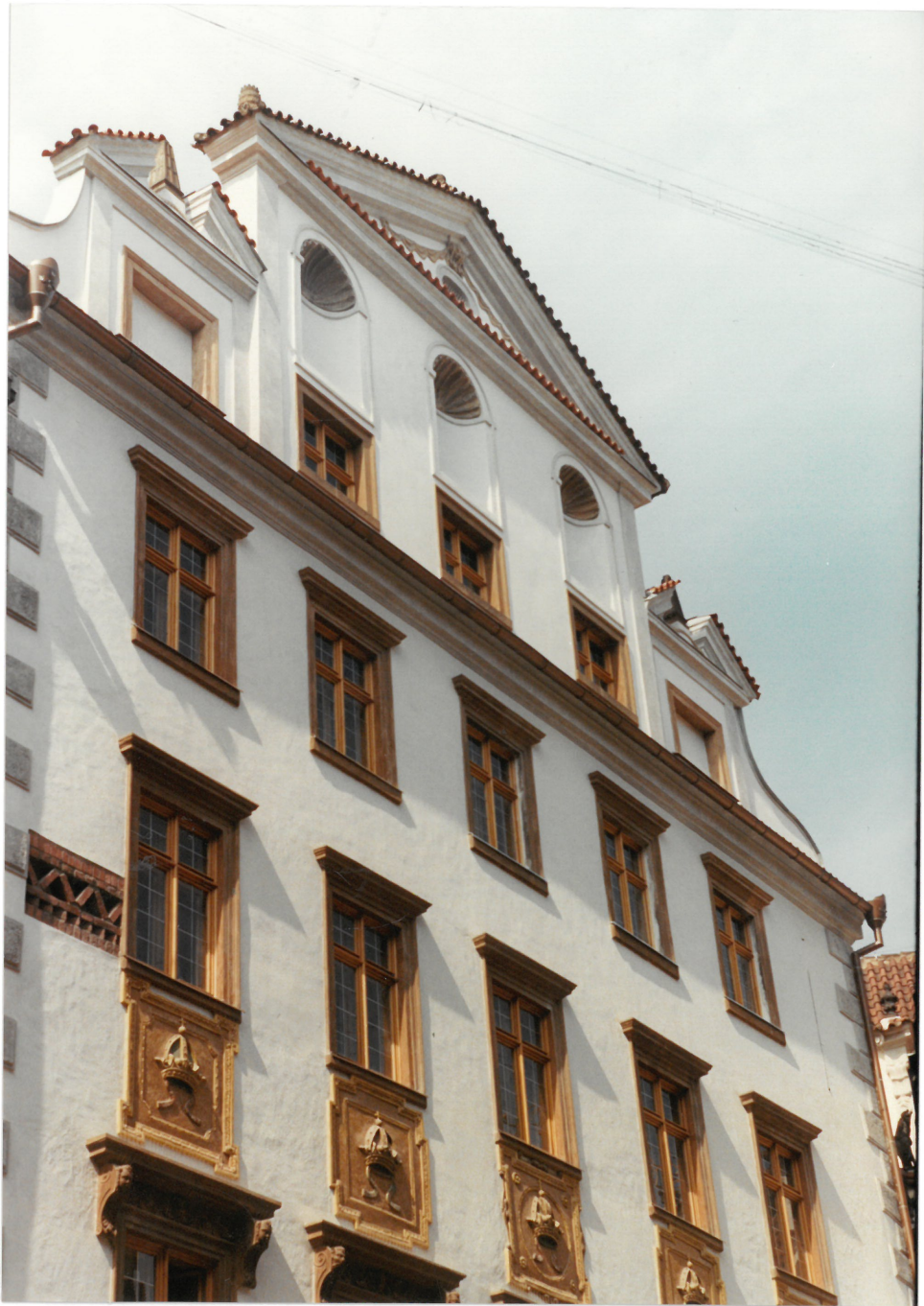
CELKOVÝ POHLED PO RESTAUROVÁNÍ
