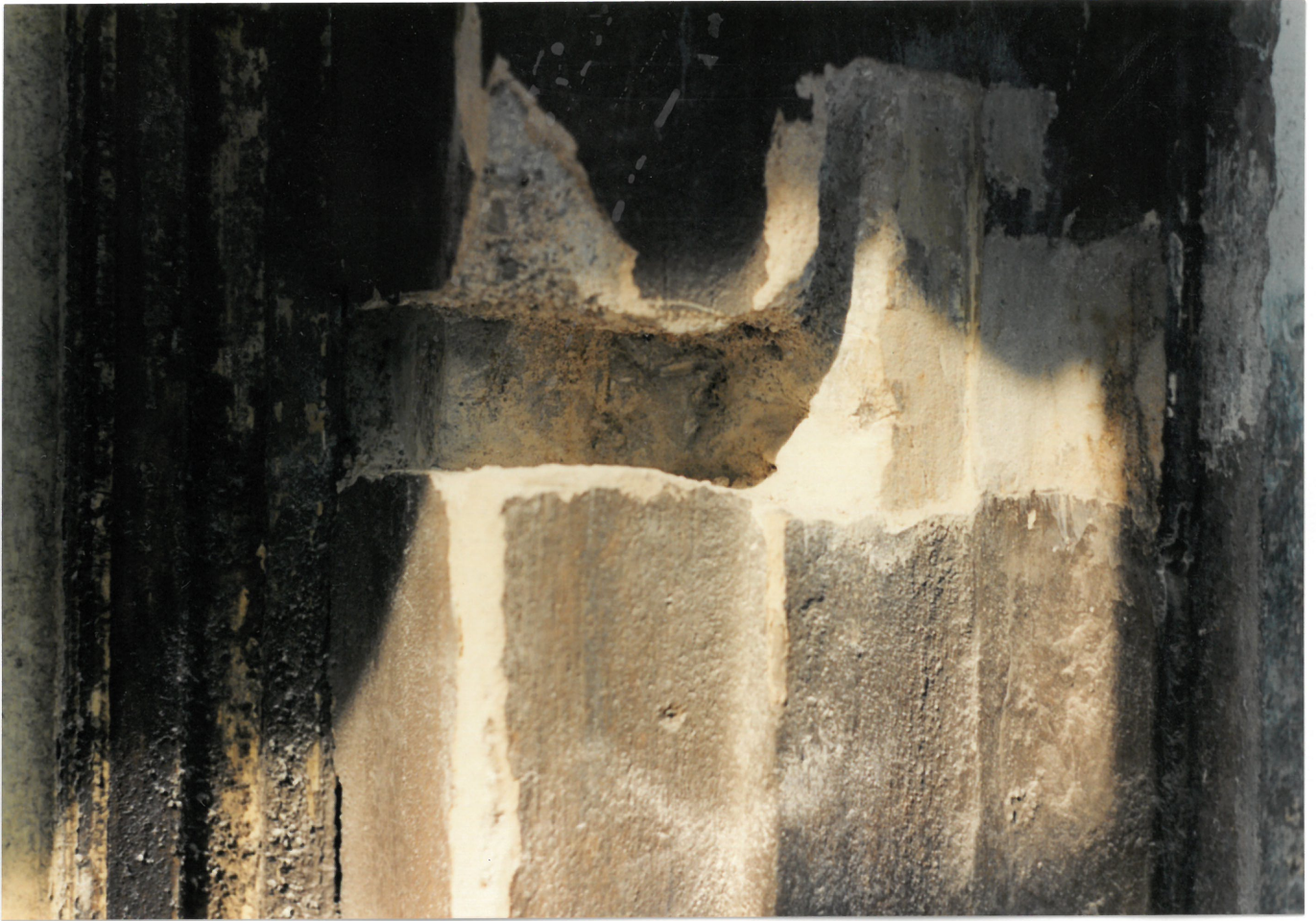
SONDA V OKENNÍM OSTĚNÍ
