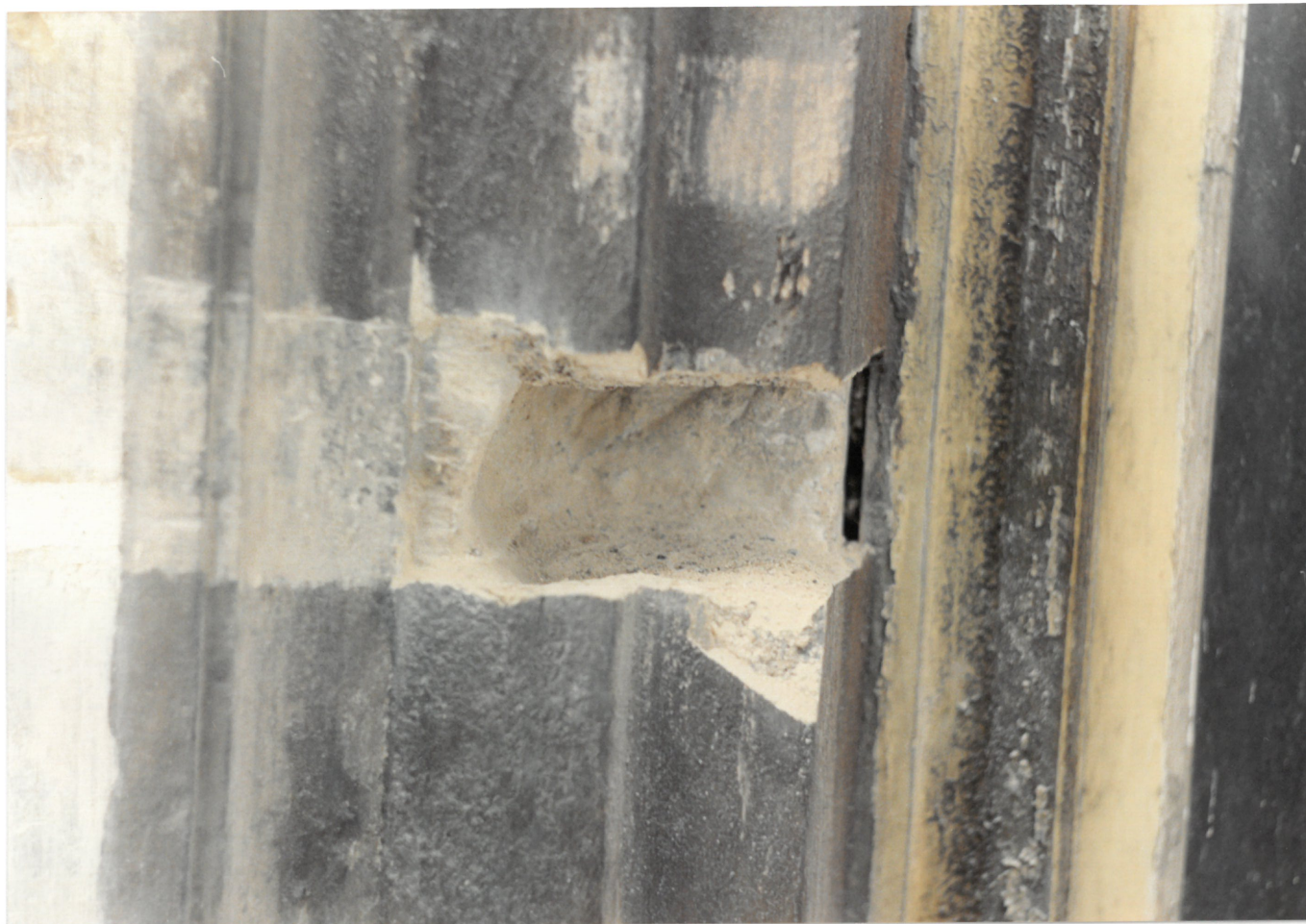
SONDA V DŘEVNÍM OSTEŇÍ
