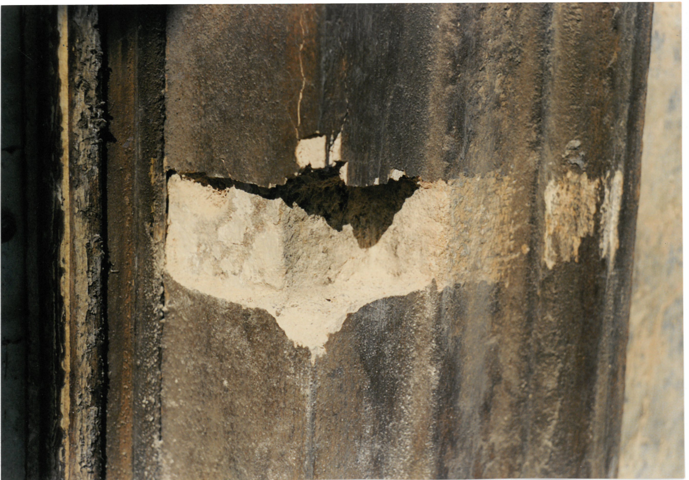
SONDA V OKENNÍM OSTĚNÍ
