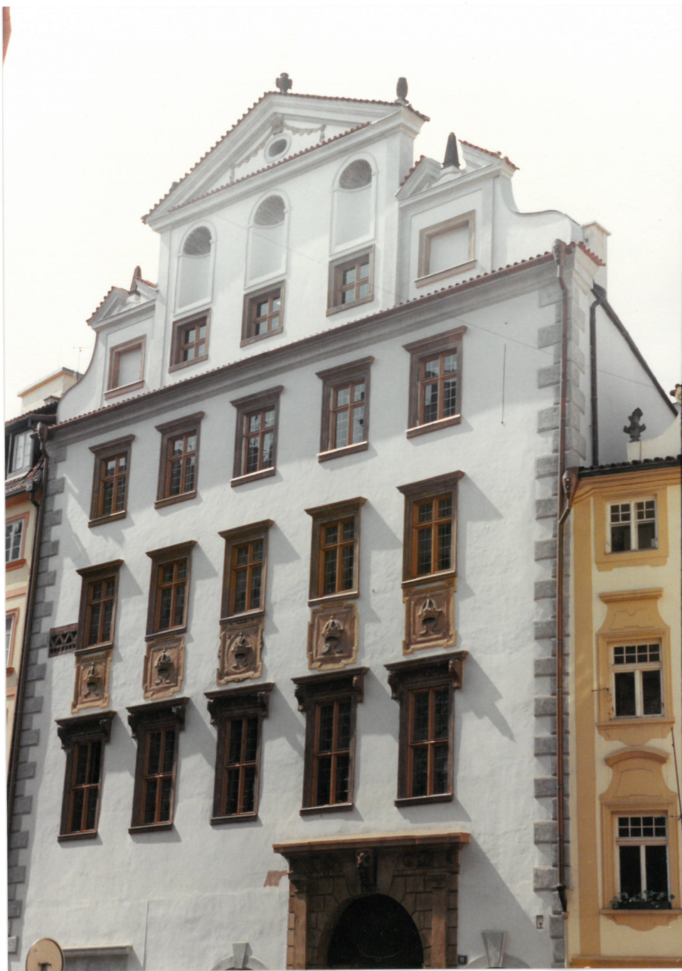
CELKOVÝ POHLED PO RESTAUROVÁNÍ
