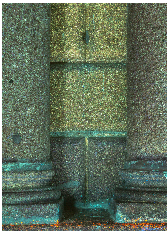
Obr. 70 Ultrafialová fluorescenční fotografie (UVF), detail žulové architektury, sloupy a bosáž.
