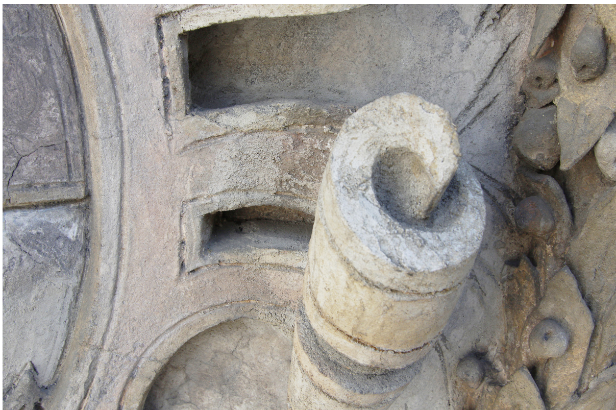
Obr. 14 Doplněná voluta v kartuši erbu Adama II.
