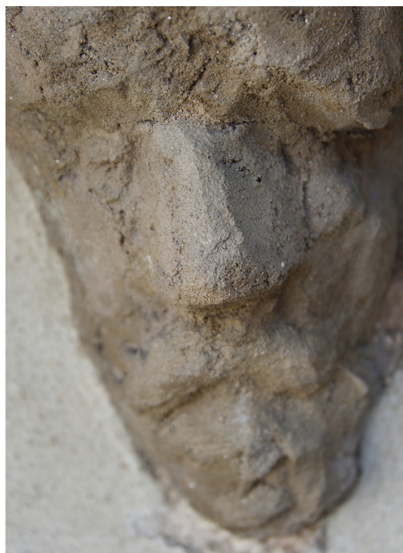
Obr. 20 Detail masky muže, doplněk nosu, celoplošné přetmelení povrchu.
