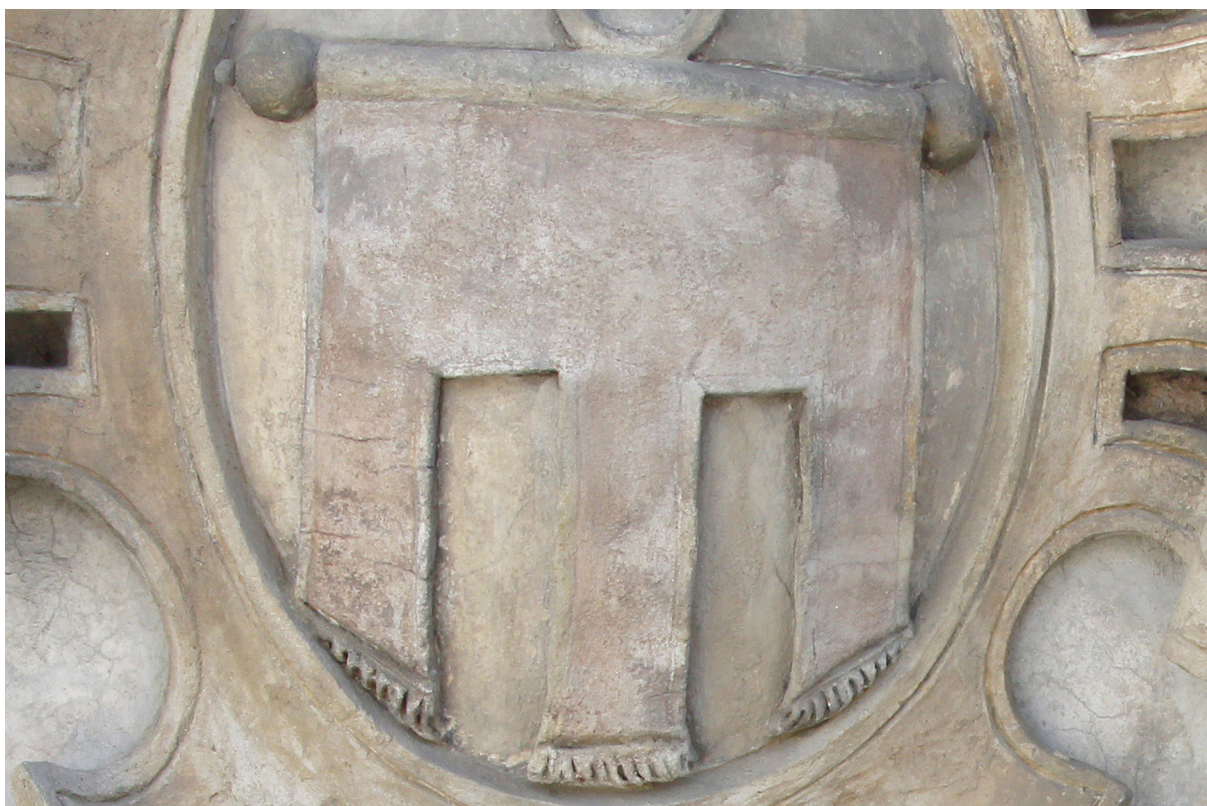
Obr. 11 Detail heraldické vlajky, gonfanonu v erbu Kateřiny z Montfortu, přetmelení povrchu, lazurní barevná retuš.
