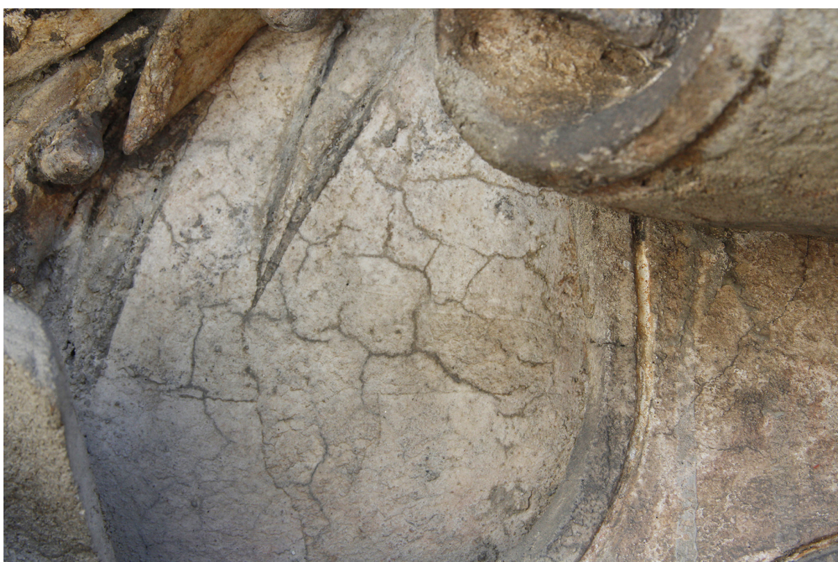
Obr. 15 Pozadí erbovní kartuše, vlevo nad erbem Adama II. rytá kresba vavřínového věnce, primární praskliny na povrchu.
