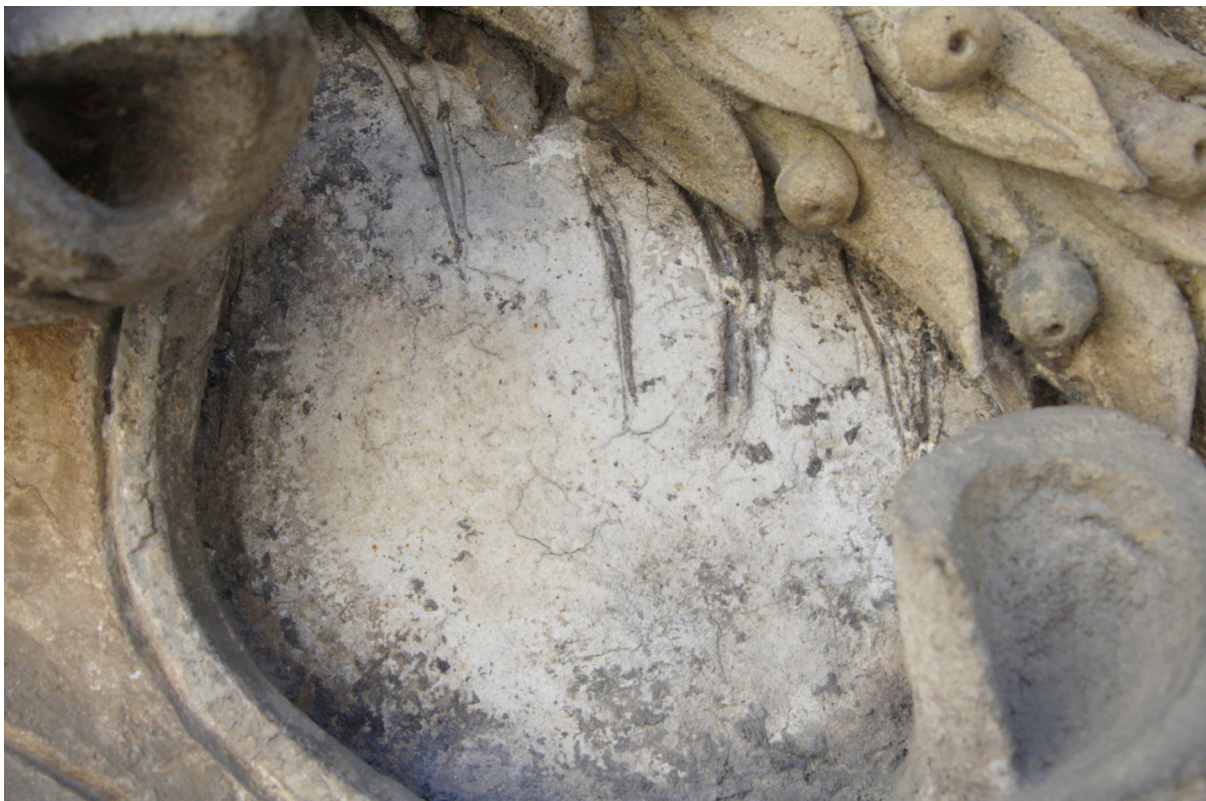
Obr. 16 Pozadí erbovní kartuše, vpravo nad erbem Kateřiny z Montfortu, rytá kresba vavřínového věnce, primární praskliny na povrchu, fragmenty polychromie.
