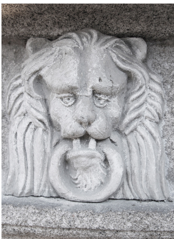
Obr. 29 Levá lví hlava na kladí portálu, detail.
