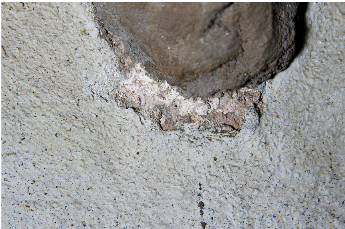
Obr. 21 Detail masky muže, fragmenty původních vápenných vrstev pod přeštukováním pozadí tympanonu.
