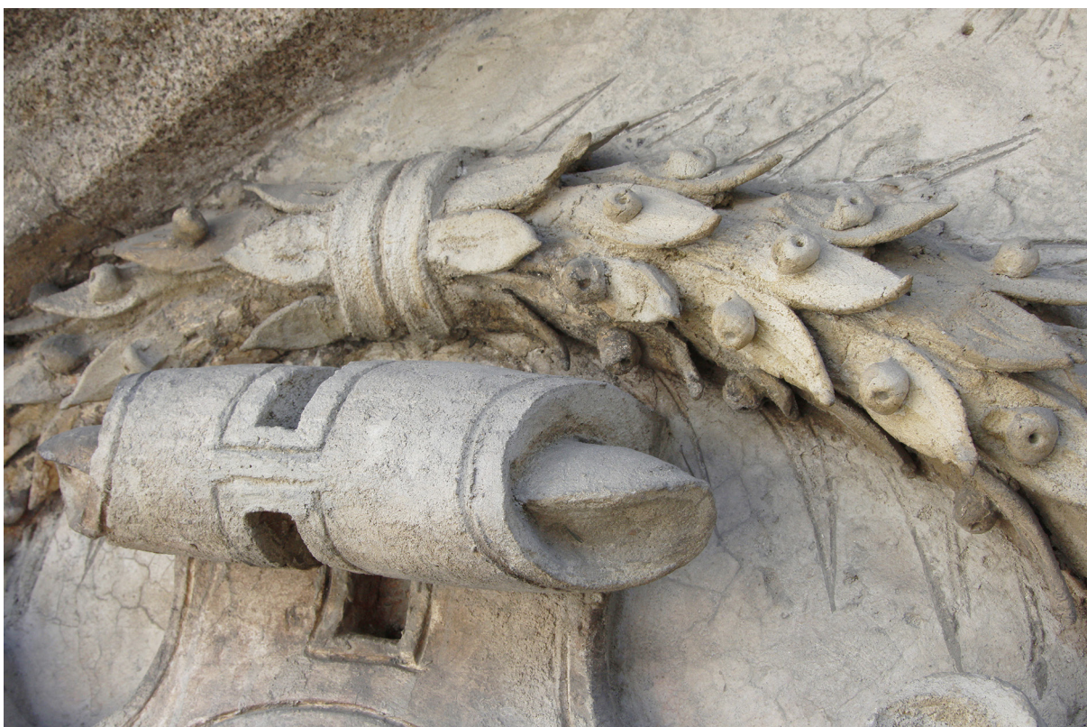
Obr. 13 Přetmelená voluta ve vrcholu kartuše erbu Adama II.
