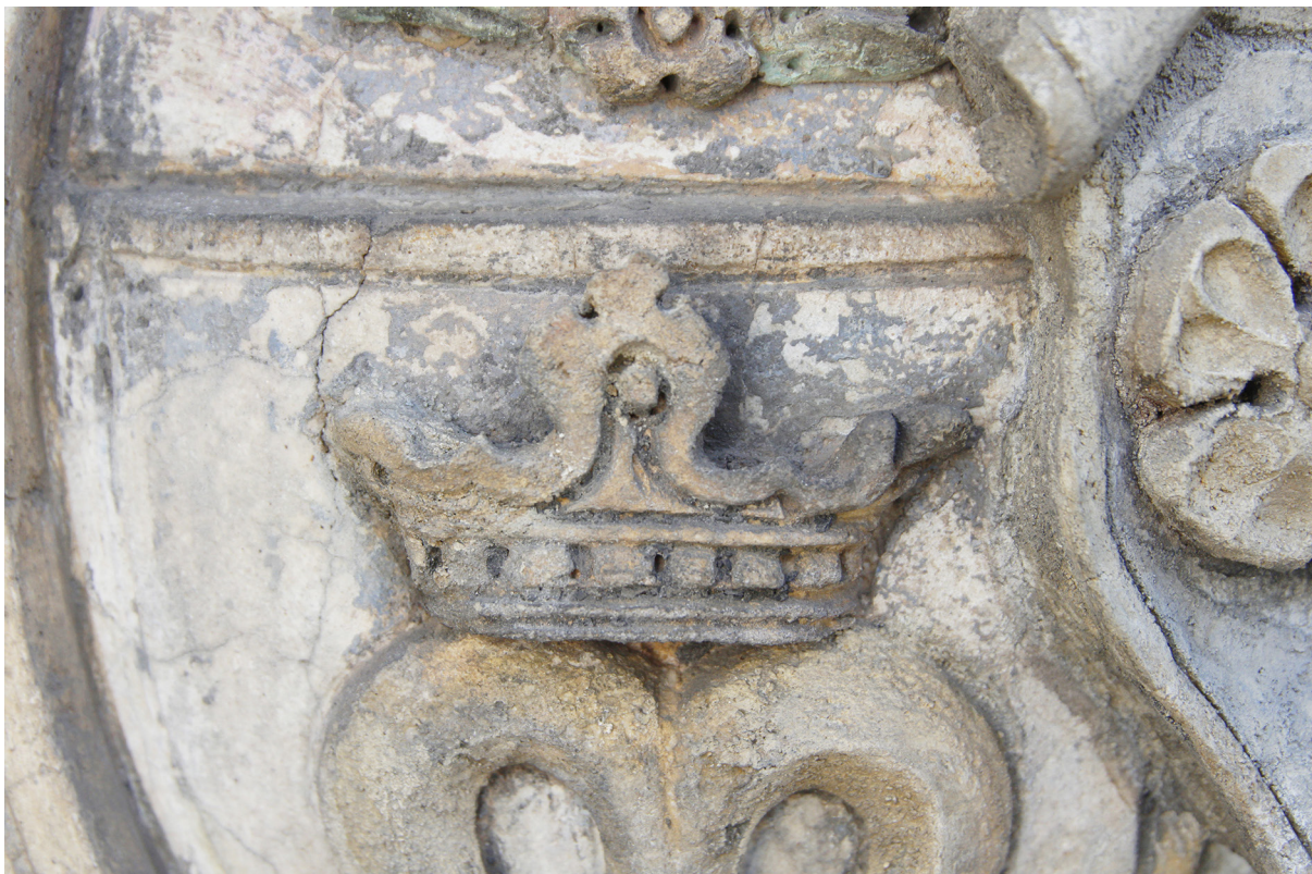
Obr. 12 Koruna písmene M v erbu Adama II, lokální přetmelení, patrné fragmenty starší polychromie.
