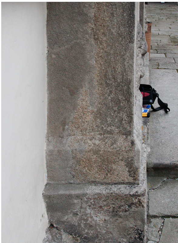
Obr. 43 Levá strana portálu, přetmelení soklových partií.
