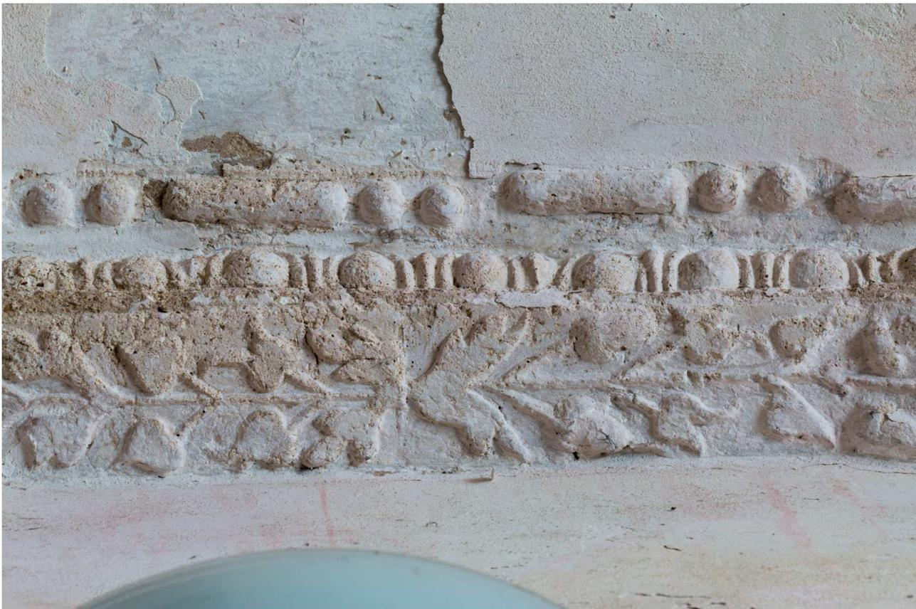
*obr. 13: detail poškození povrchu ornamentu, druhotné štukové vrstvy na ploše klenby*
