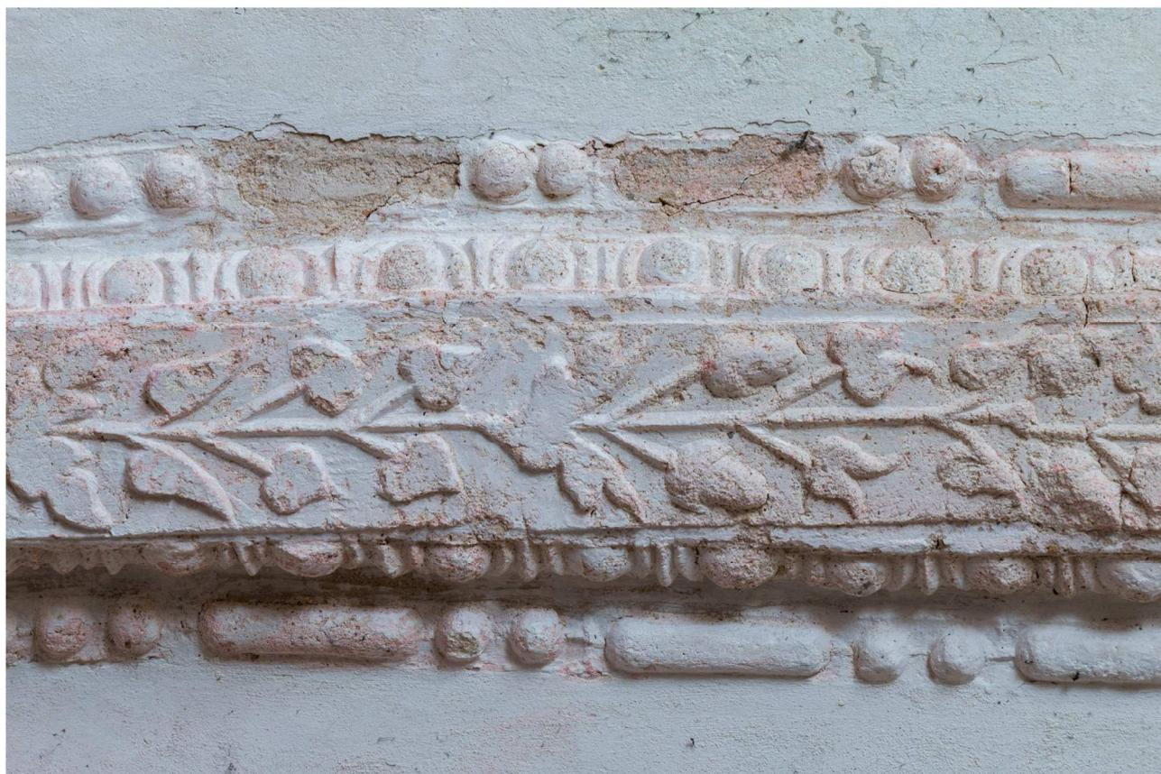
*obr. 14: detail poškození povrchu ornamentu, chybějící prvky perlovce*
