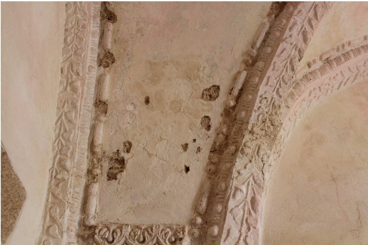
*obr. 17: poškození JV cíp klenby*
