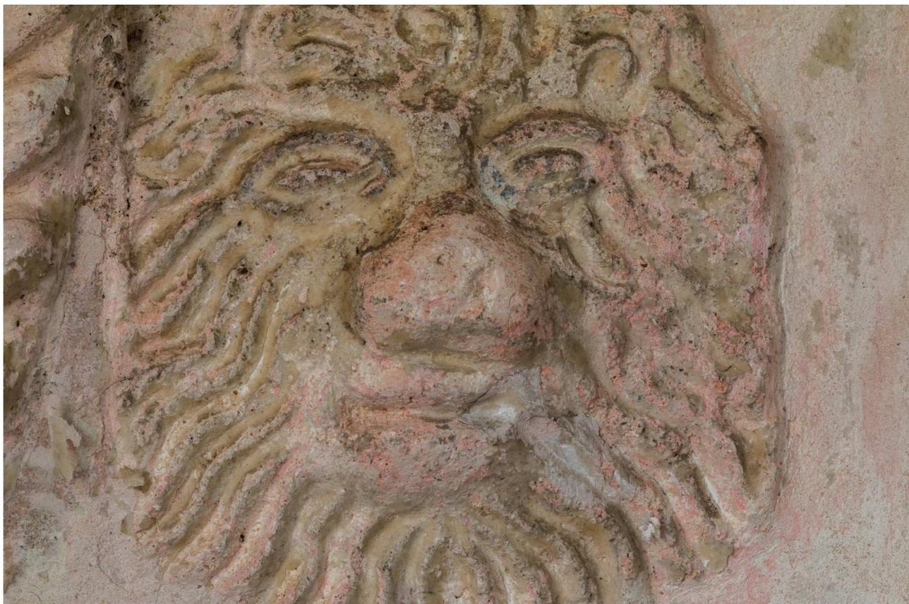
*obr. 15: detail maskaromu lva, SZ, zaslepení povrchu sekundárním separantem, sádrový doplněk nosu*
