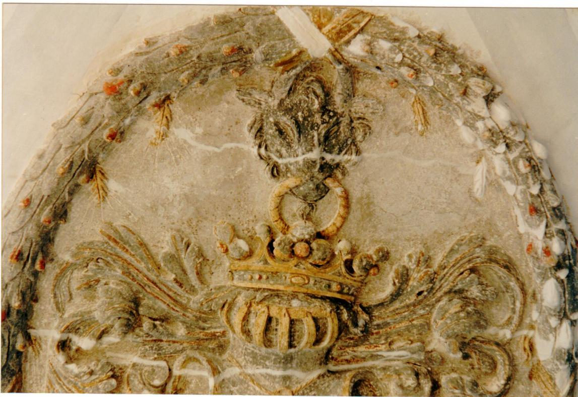
HORNÍ ČÁST ERBU PO OCÍSTĚNÍ A VYTMELENÍ PRASKLIN.
