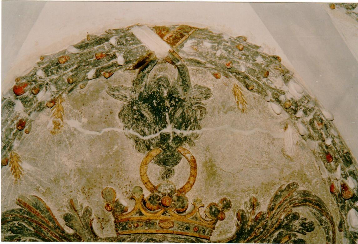
HORNÍ POLOVINA ERBU PO OČIŠTĚNÍ, VYTMELENÍ PRASKLIN
