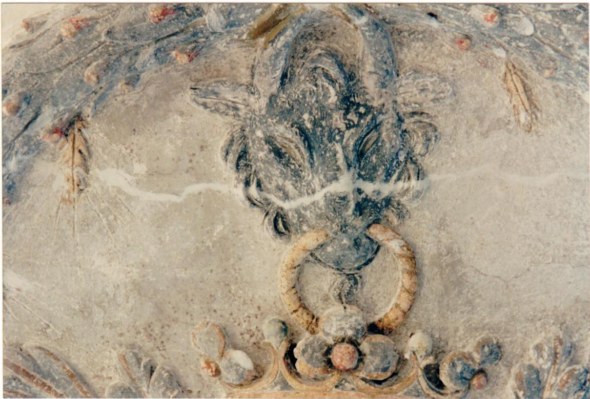
DETAIL Z HORNÍ ČÁSTI ERBU - STAV PO OČIŠTĚNÍ A VYTMELENÍ
