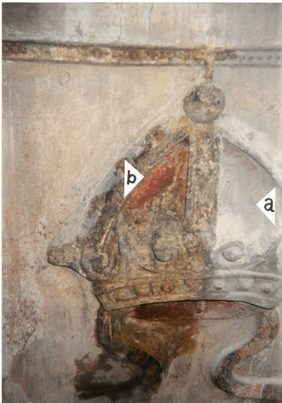
a/ stav před opravou b/ původní odkrytá polychromie
