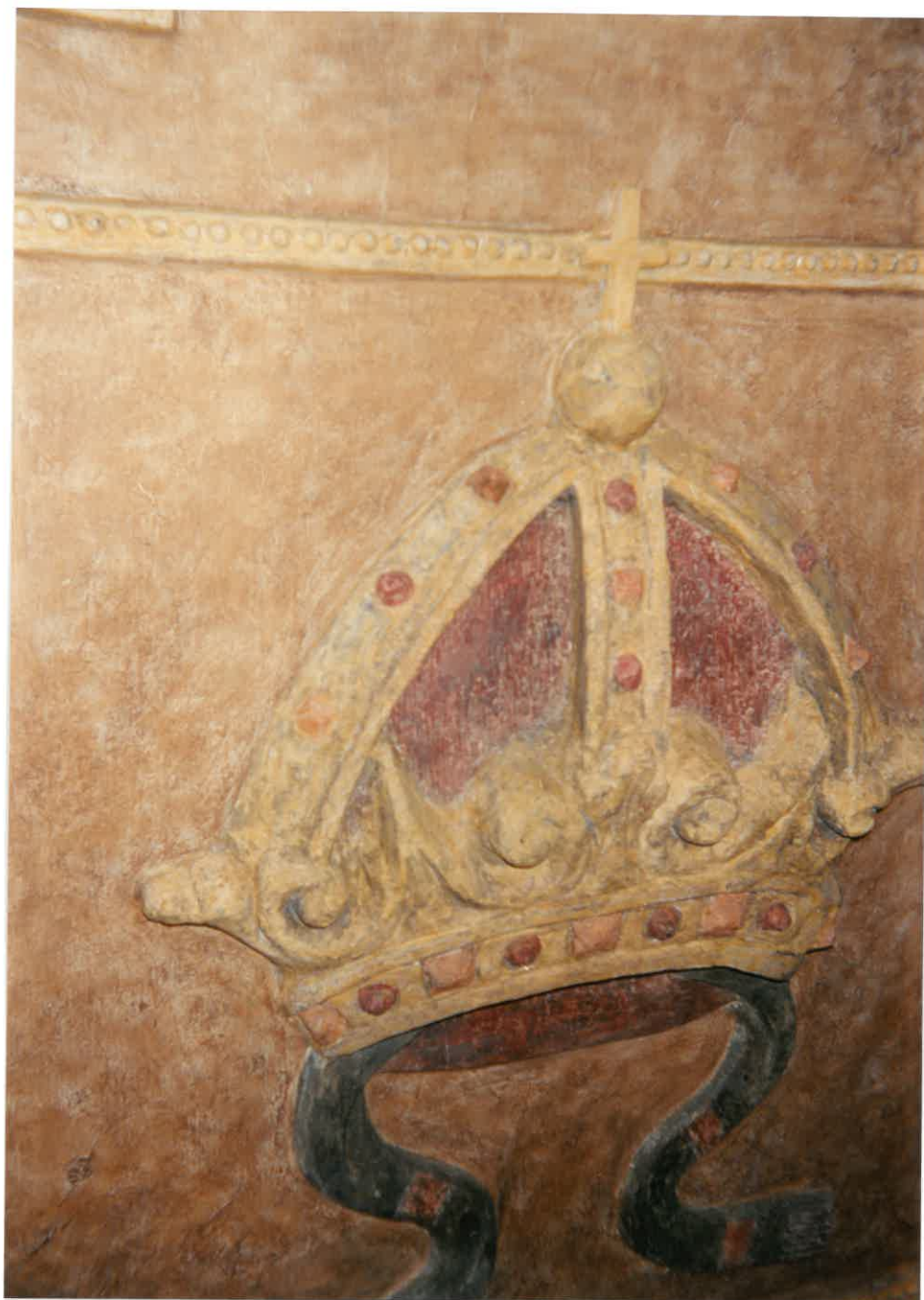
Stav po opravě
