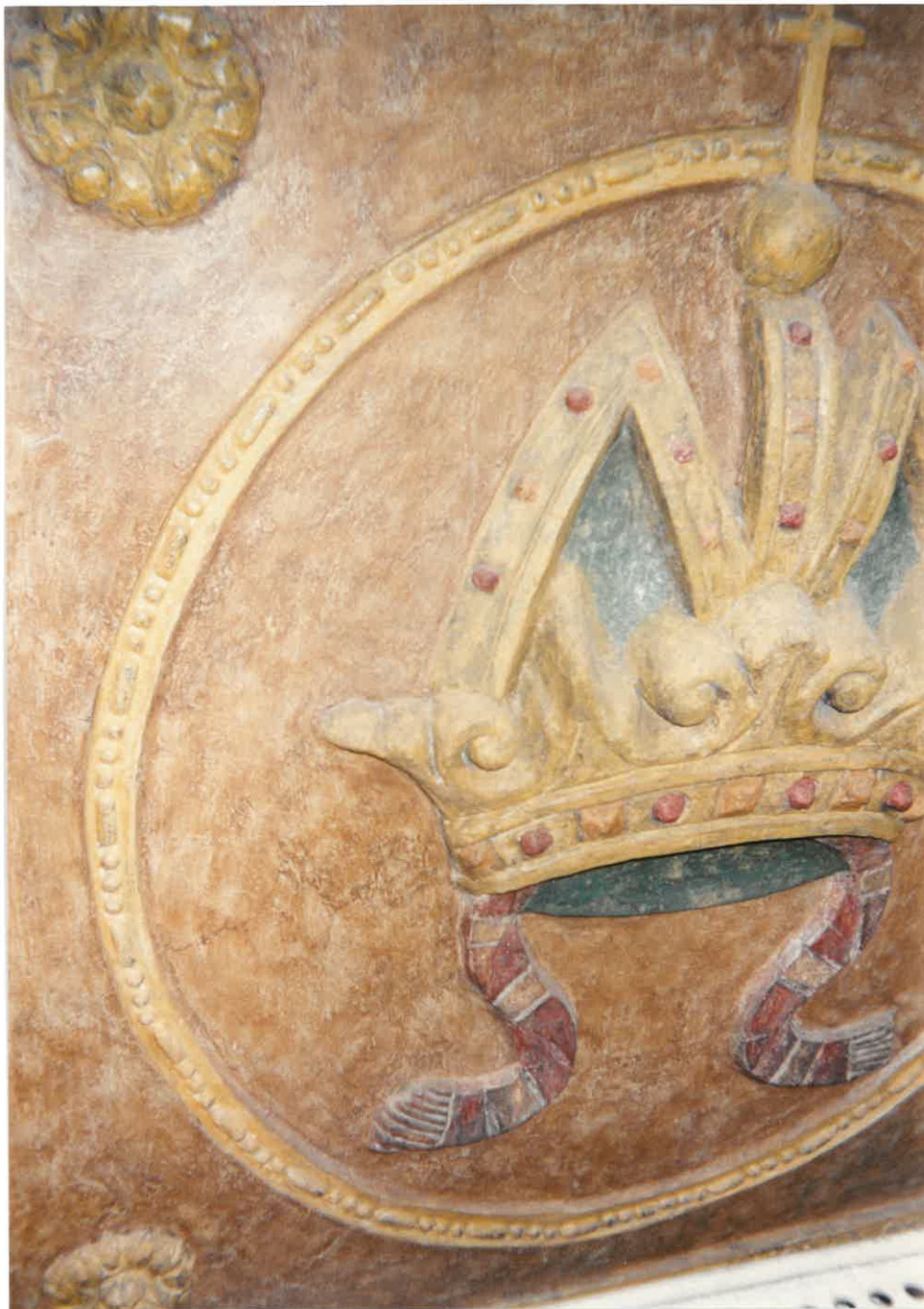
Stav po opravě
