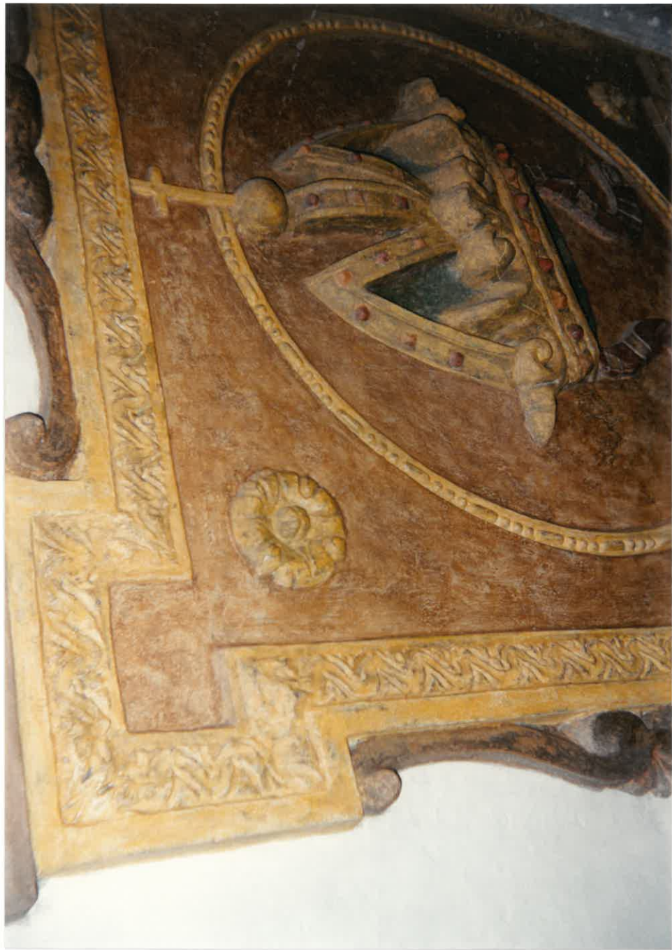
Stav po opravě
