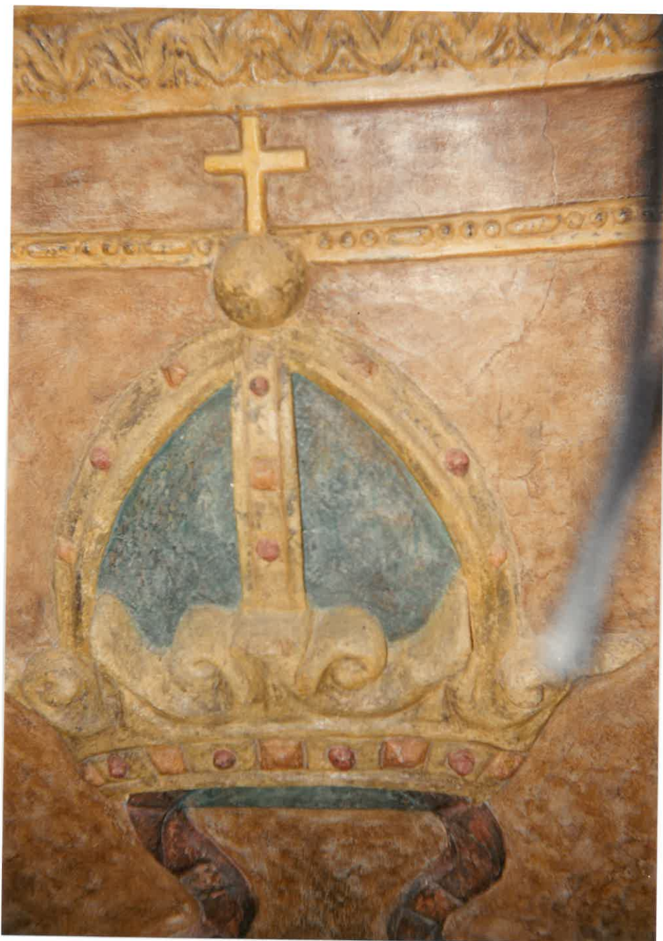
Stav po opravě
