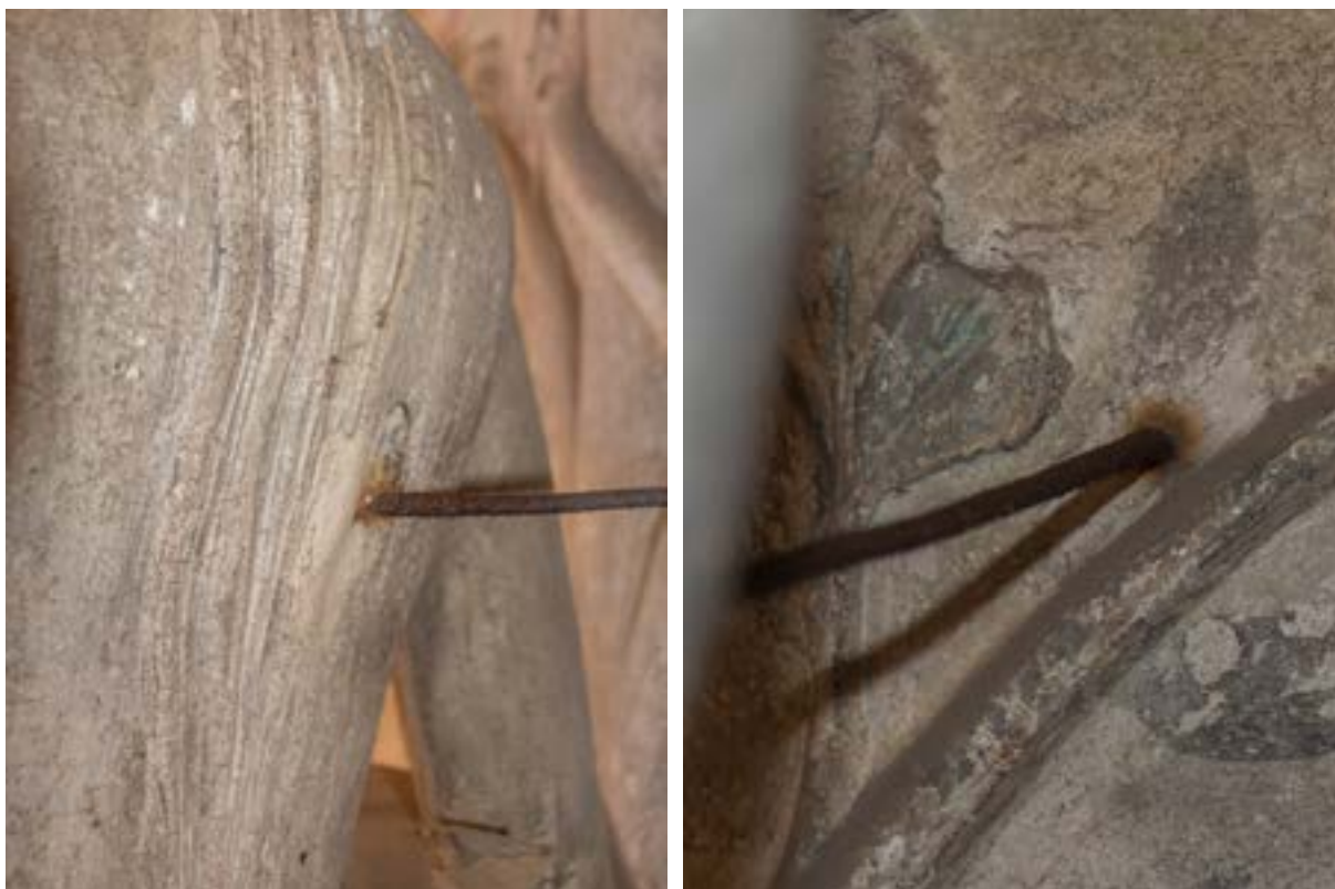
Obr. 14 Záda Evy se stávajícím kotvením pomocí ocelového drátu (vlevo). Ukotvení drátu do zdi výklenku (vpravo).
