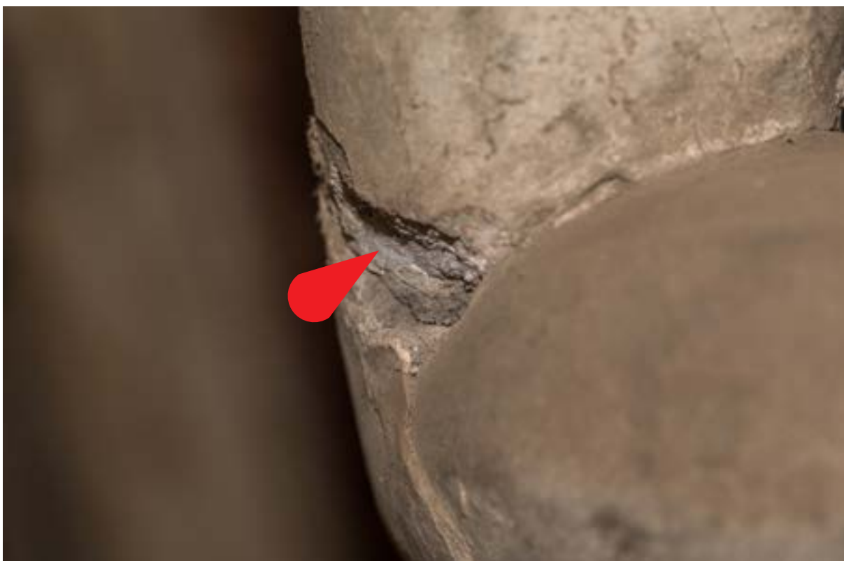
Obr. 18 Prasklina s chybějící štukovou vrstvou v oblasti lokte Evy.
