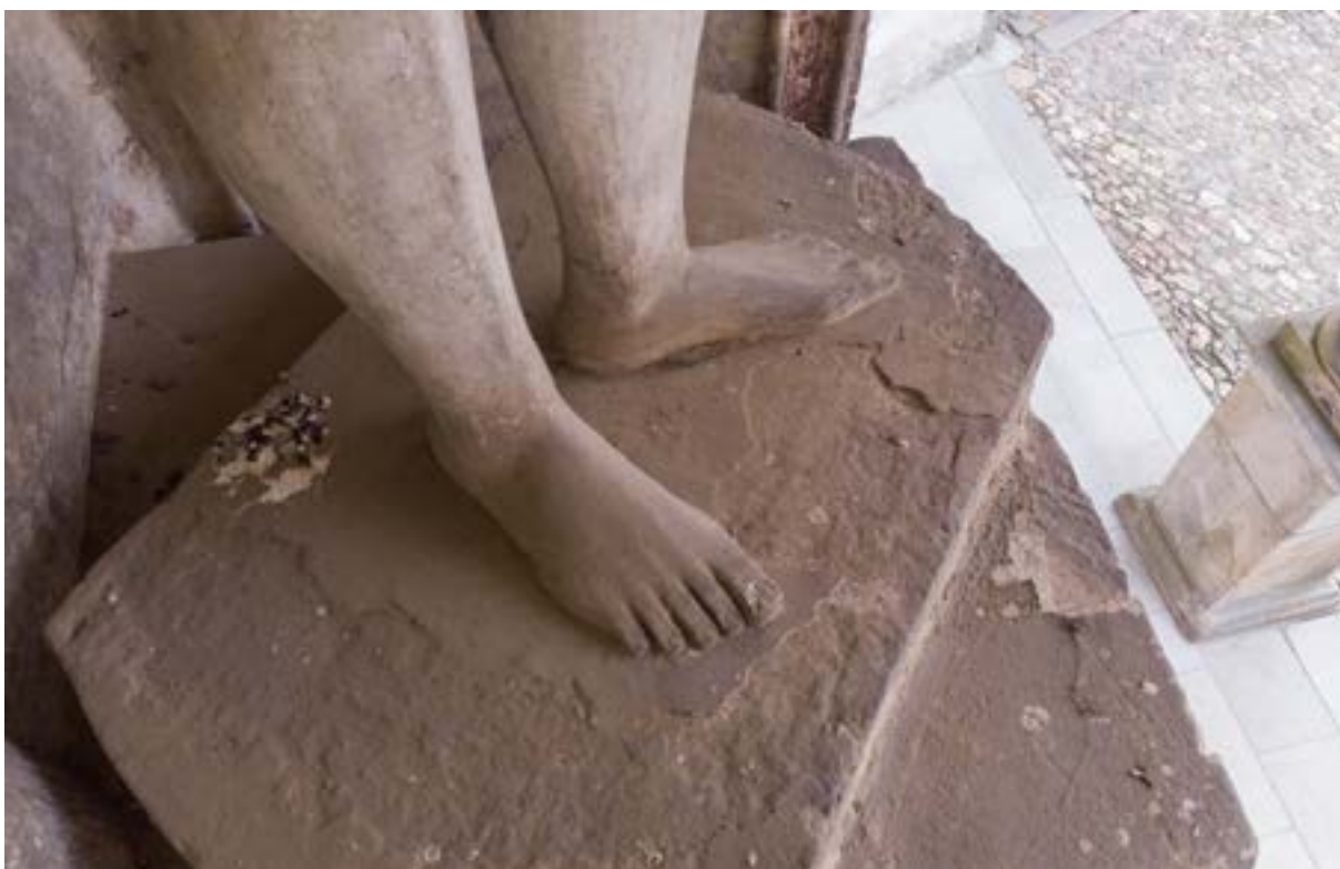
Obr. 23 Podstavce pod sochami jsou pokryty vrstvou depozitu včetně holubiho trusu a jejich degradace rovněž souvisí s působením vodorozpustných solí.
