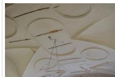
Praha, Dům u Drahomířina sloupu, klenba místnosti v 1. patře (Robert Gája, 2022)
