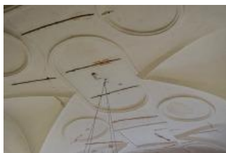
Praha, Dům u Drahomířina sloupu, klenba místnosti v 1. patře (Robert Gája, 2021)
