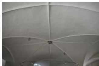
Bruntál, zámek, přízemní místnost v severním nároží (Pavel Waisser, srpen 2019)
